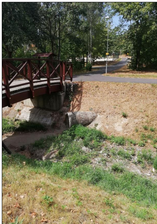
Obr. č. 16 – Výústní objekt OK 4 (Egerová, 2018)
