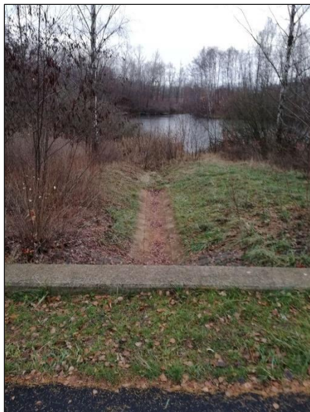
Obr. č. 21 – odvodňovací strouha z městské části Hamr – zaústění do nádrže Šedák (Egerová, 2018)
