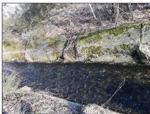
Obr. č. 11 – Koryto Bílého potoka pod přítokem (Egerová, 2018)
