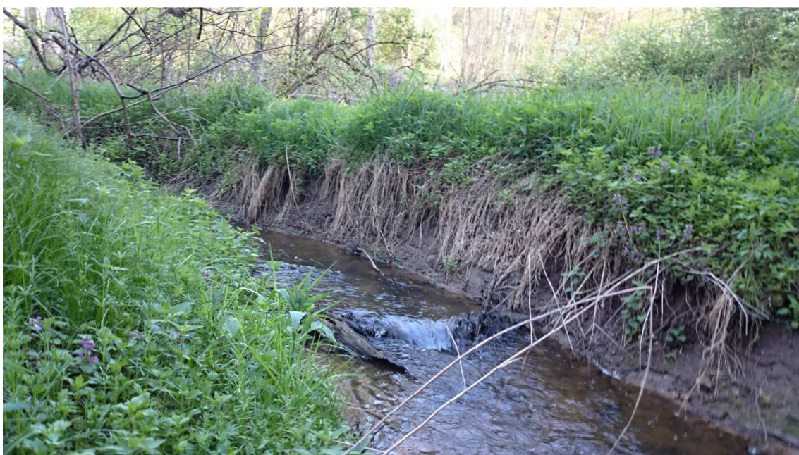
Obrázek č.11: Foto současné odtokové stoky pod hrází nádrže
