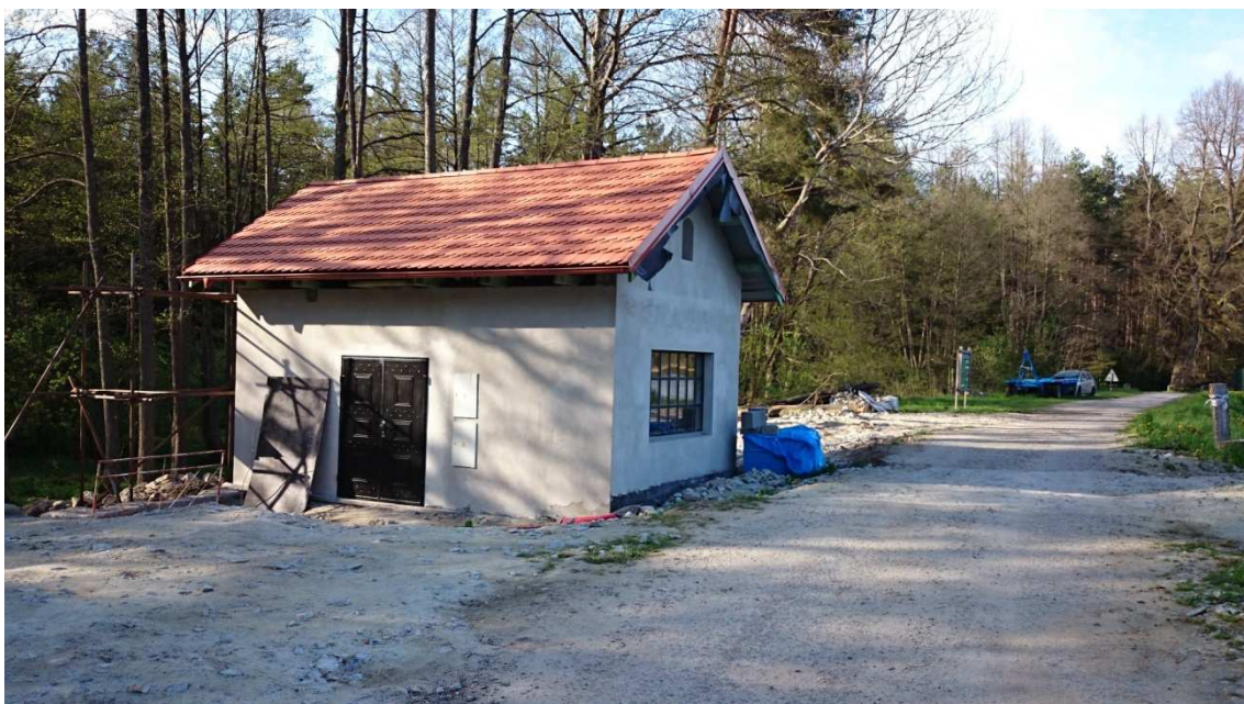
Obrázek č.12: Foto budovy MVE (stav k 8.5.2015)
