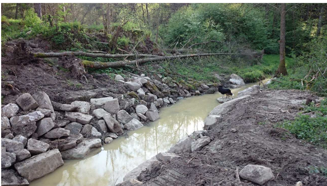
Obrázek č.13: Foto budované odtokové stoky z MVE (stav k 8.5.2015)
