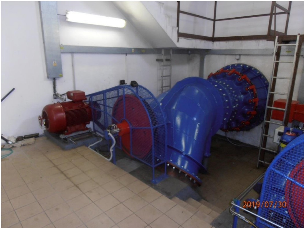
Obrázek 18: Kaplanovy turbíny MVE Počáply
