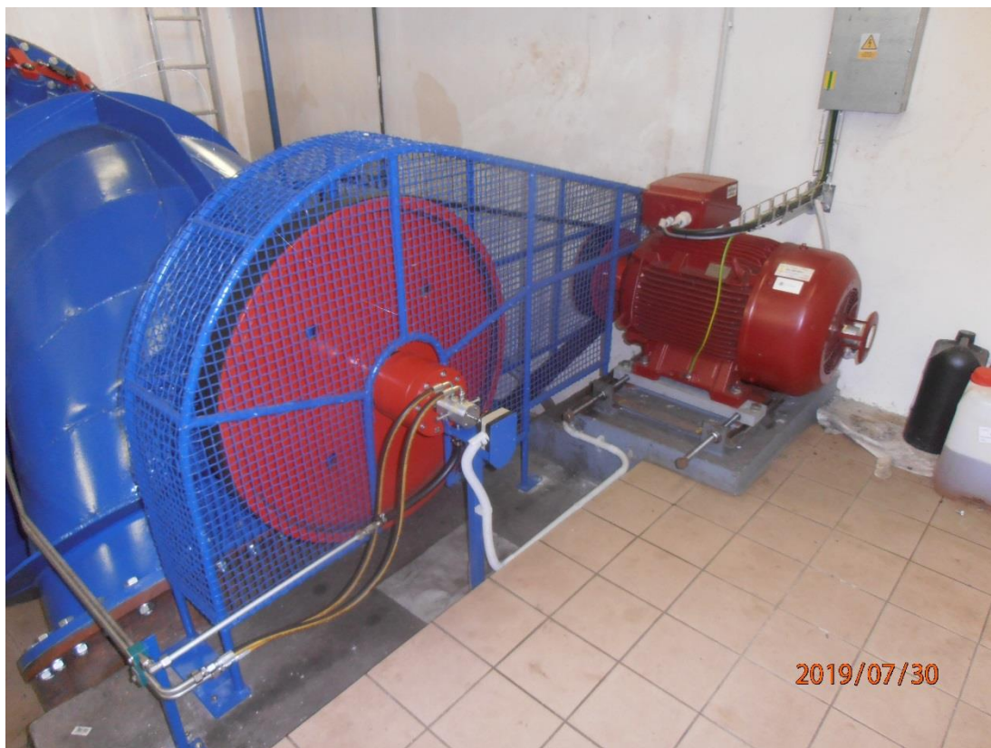
Obrázek 20: Generátor a převod MVE Počápy
