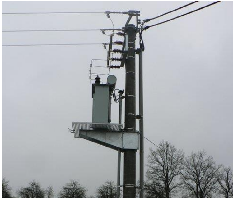
Obrázek P-3: Stožárová transformační stanice [28]
