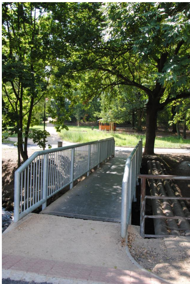
Obrázek č. 61: Pohled na mostek přes řeku Bílinu
