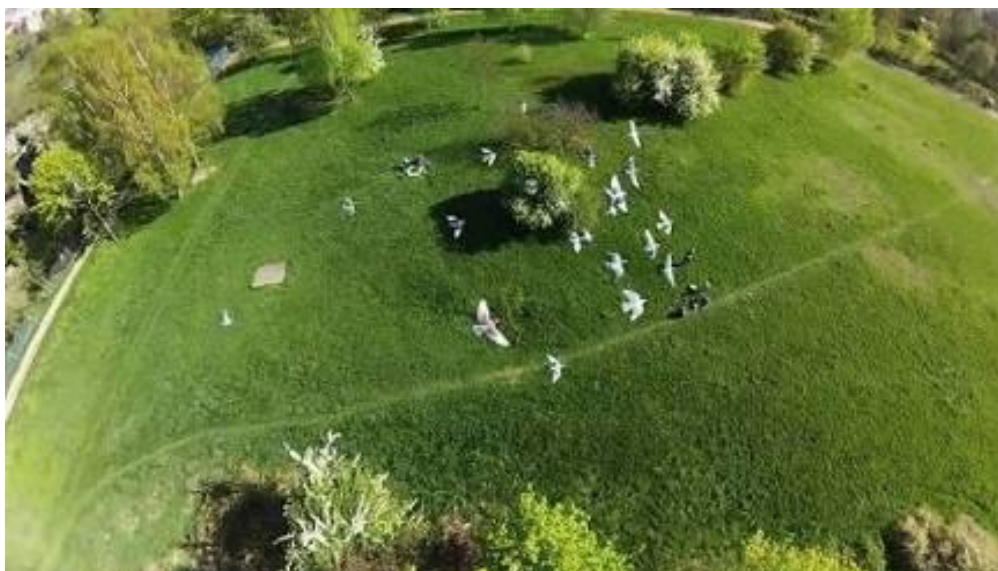
Obrázek č. 10: Pohled na hlavní travnatou plochu před prováděnou rekonstrukcí, levá strana ve směru toku Bíliny
