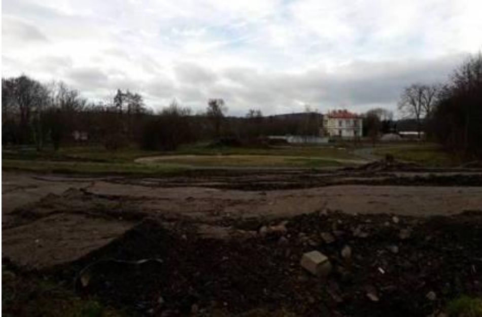
Obrázek č. 14: Pohled na začátek prací na rekonstrukci parku
