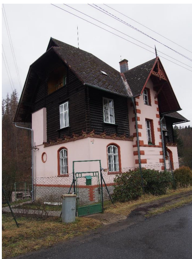
98. Ernst Latzel, vila neznámého majitele, 1897, východní průčelí, zřetelná je zazděná lodžie při levém okraji fotografie, současný stav.
