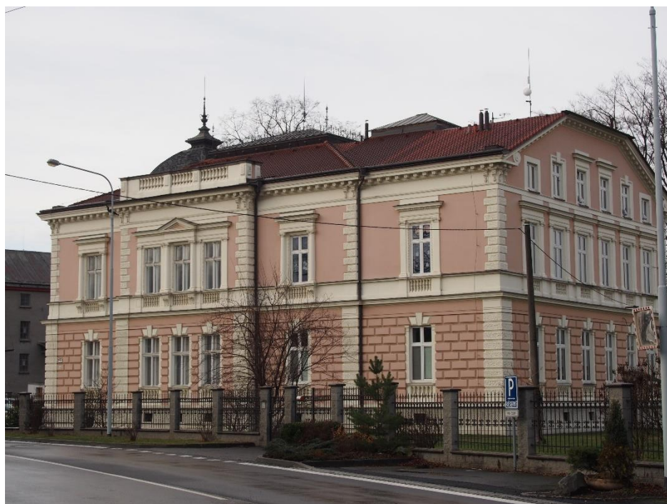
82. Josef Hartel, vila Gustava Kandlera, 1892, pohled na východní (uliční) a severní (zadní) průčelí, kde je zřetelná přístavba, současný stav.
