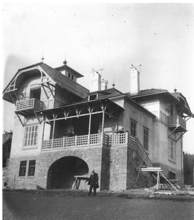
128. Josef Nebehosteny, vila Floriana Schmidta jun., 1904, zahradní průčelí, veranda je oproti původnímu návrhu značně vyvýšena.
