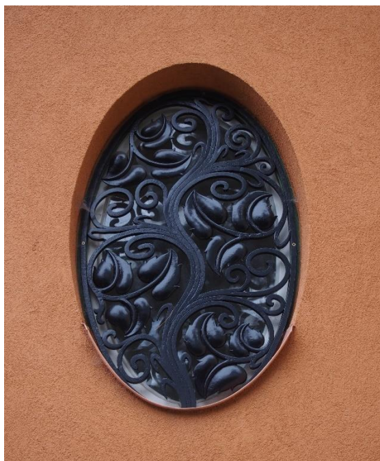
183. Otto Prutscher, vila Theodora Flemmicha, 1914-1917, oválné okno s mříží dekorovanou florálními rozvilinami, současný stav.
