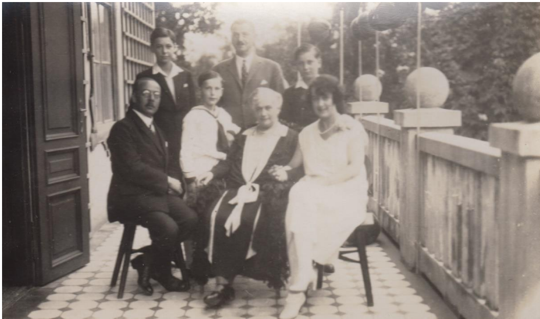
159. Ježník 1874/40, Krnov, vila Aloise Chlupačka, kolem roku 1910, pohled z terasy východním směrem, rodinná fotografie dokládá, že dřevěnou konstrukci nechali odstranit ještě původní majitelé.
