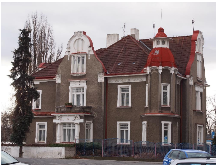
144. Rudolf Heiner, firma Eduard Frank, vila firmy Rürger & Comp., plánová dokumentace, 1906, východní průčelí, současný stav.
