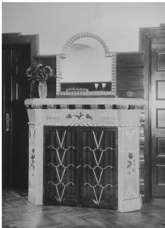
115. Otto Prutscher, vila Dr. J. Schnürcha, 1927, ústřední topení nainstalované v krbech z leštěného kamene z ozdobnými kovovými mřížemi.
