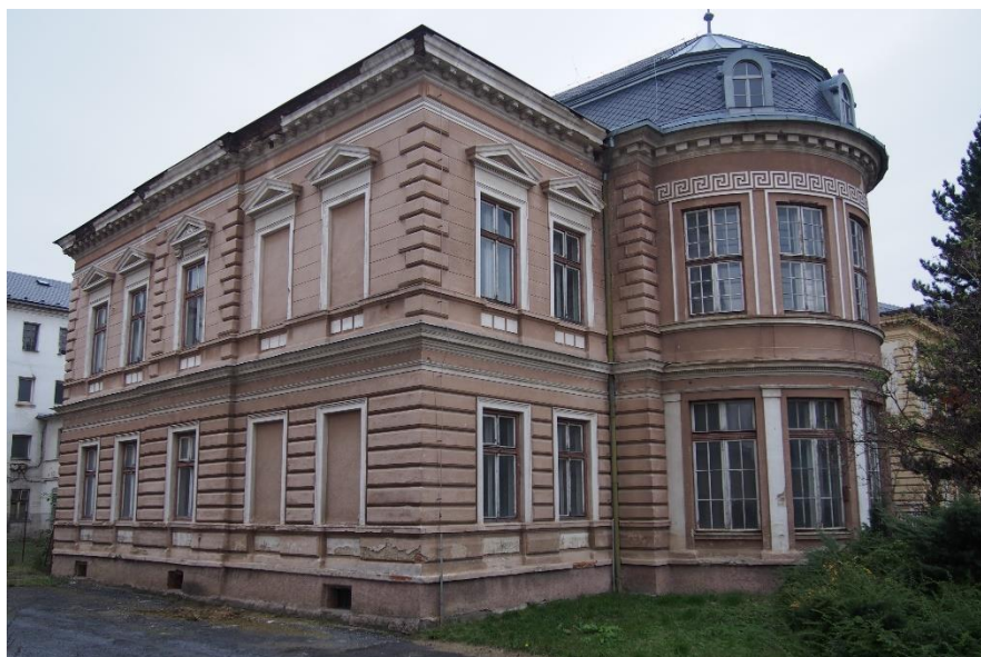
46. Leopold Bauer, vila Hermanna Larische, původně K. Larische, 1911-1912, exteriér vily, pohled od jihozápadu, současný stav.
