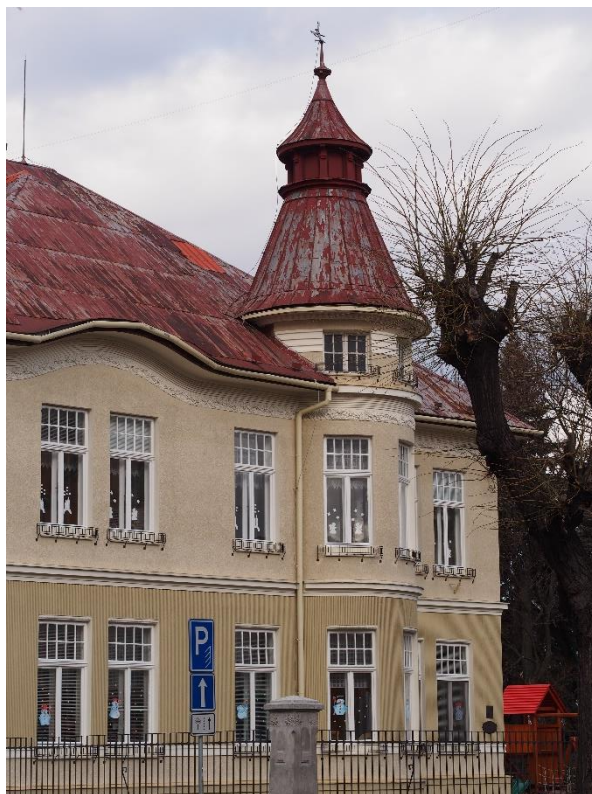
167. Firma Josef Hartel, vila Eugena Lindnera, plánová dokumentace, 1912, pohled od jihozápadu na uliční průčelí, současný stav.
