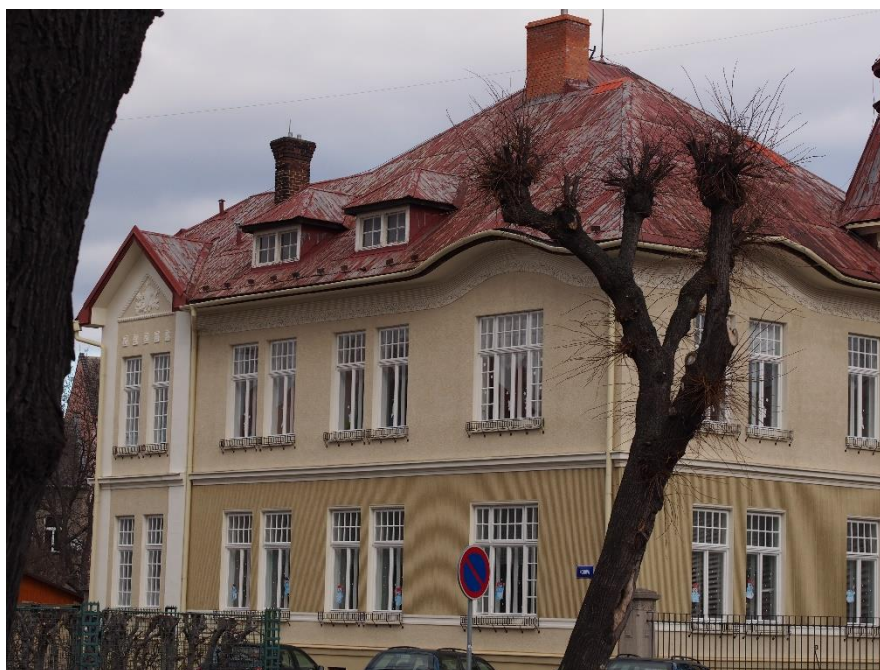
168. Firma Josef Hartel, vila Eugena Lindnera, plánová dokumentace, 1912, pohled na západní průčelí.
