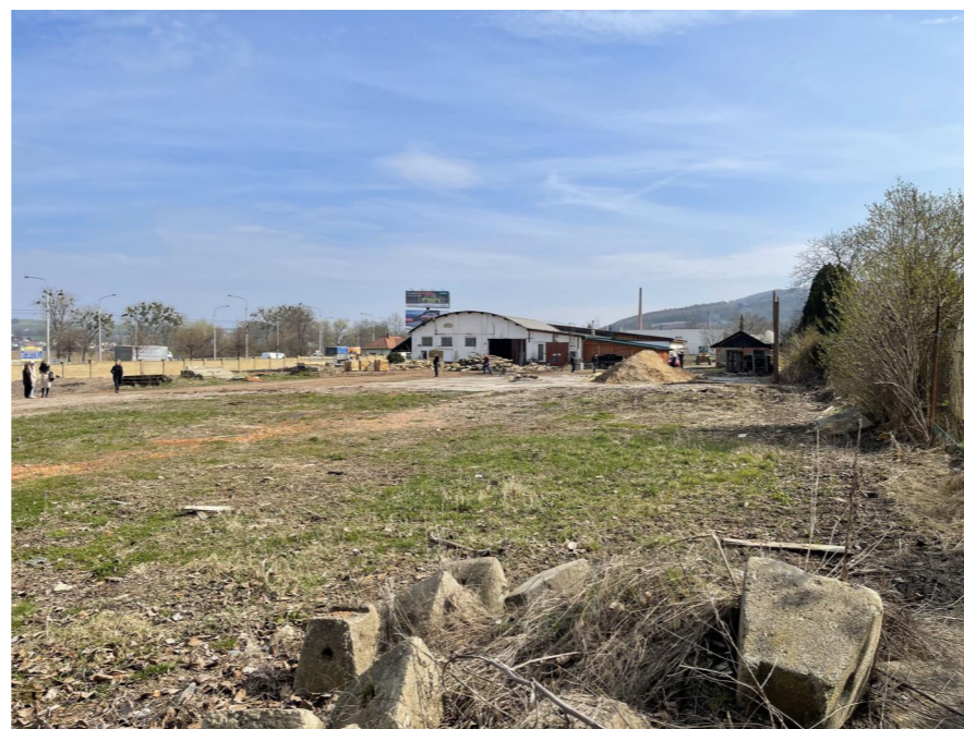
Pohľad na spomínanú skladovú halu a príľahlé objekty, ktoré sa dnes využívajú len sporadicky. Pozemok je široký 70m a dlhý 250m. Jeho plocha aj s vedľajším parkoviskom je približne 1,9ha.
