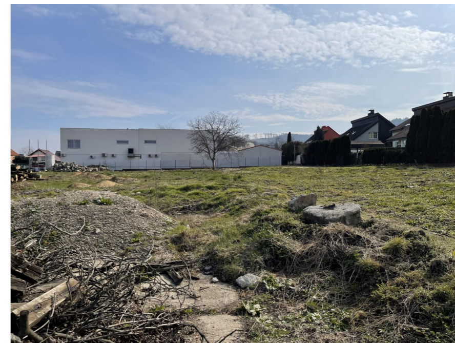
Záber na budovu požičovne stavebnej techniky v západnej časti. Brownfield Malenovickej píly je dnes prevažne prázdny s pozostatkami reziva a halového objektu v centrálnej časti. Pozemok je mierne svahovitý s prevýšením cca 2,5m.
