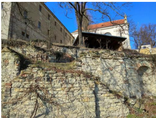
Obrázek 37 Opukové zdivo a schodiště
