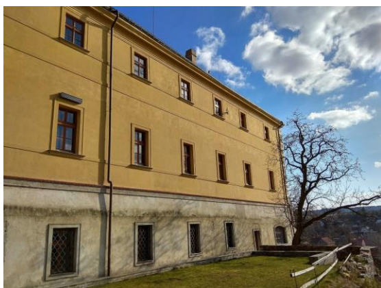
Obrázek 33 Obnova západního křídla z roku 2016
