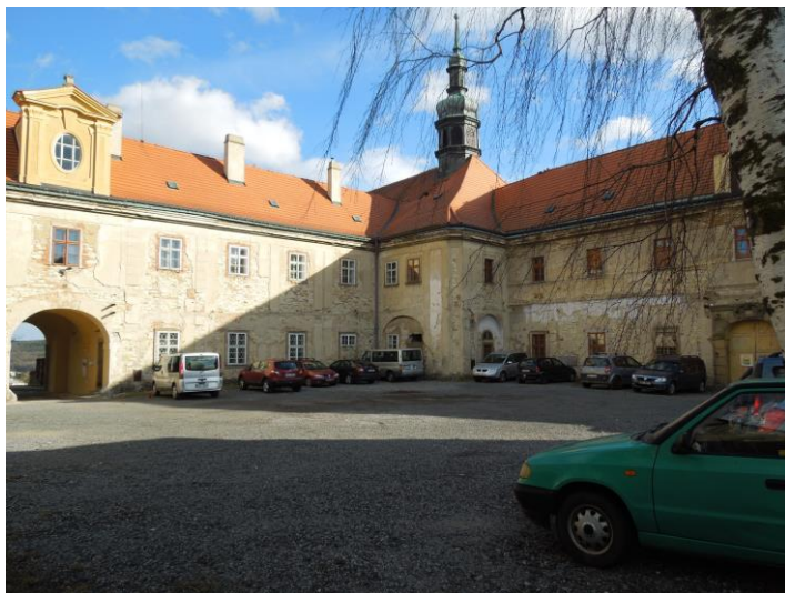
Obrázek 31 Pohled do hospodářského dvora
