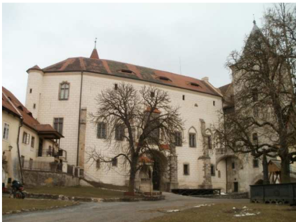
Obr. č. 41 – západní křídlo z dolního nádvoří
