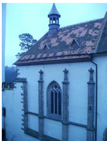
Obr. č. 63 – jižní křídlo
