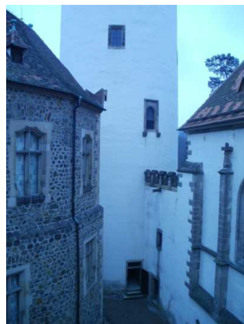
Obr. č. 67 - obytná věž
