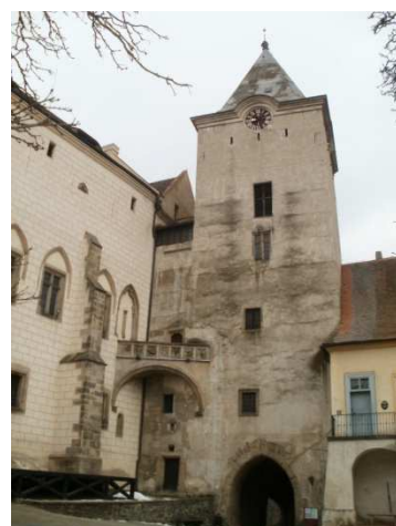
Obr. č. 24 – Prochoditá věž
