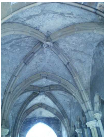
Obr. č. 49 – klenba v průchodu
