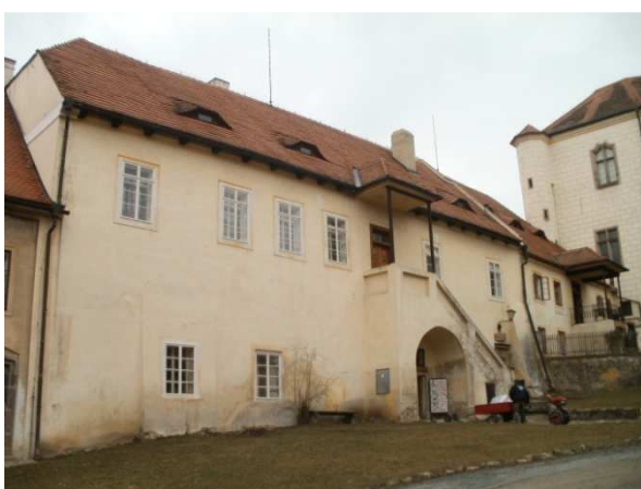
Obr. č. 37 – budova s kovárnou
