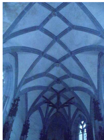
Obr. č. 77 – klenba kaple
