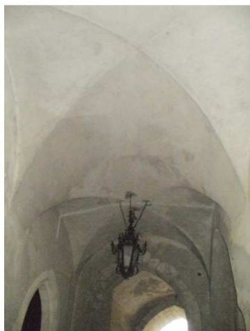
Obr. č. 21 – klenba v průchodu
