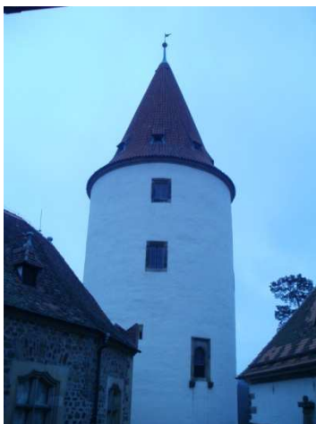
Obr. č. 66 – obytná věž
