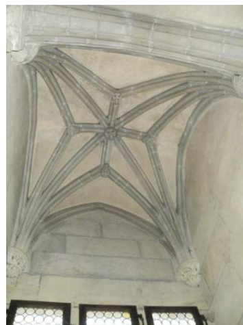
Obr. č. 73 – klenba vyvýšeného prostoru v předsíni
