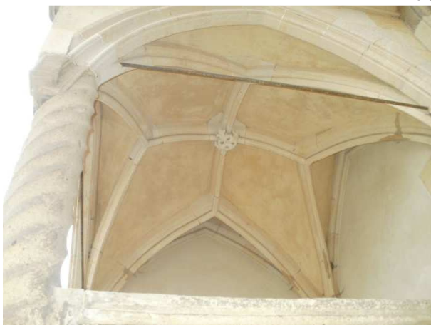
Obr. č. 46 – klenba vrátnice
