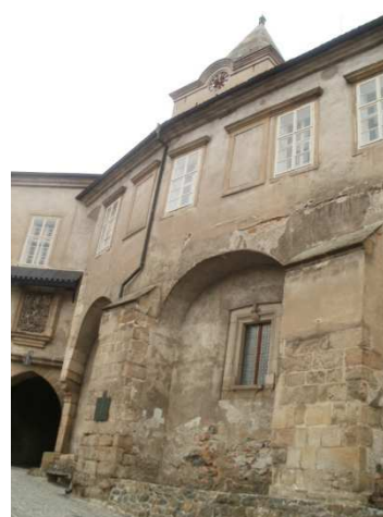
Obr. č. 16 – stavba se slepou arkádou
