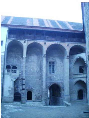
Obr. č. 51 – západní křídlo z horního nádvoří
