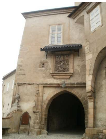
Obr. č. 17 – Prochoditá věž
