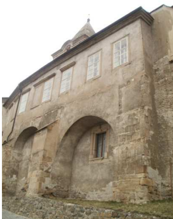
Obr. č. 15 – stavba se slepou arkádou
