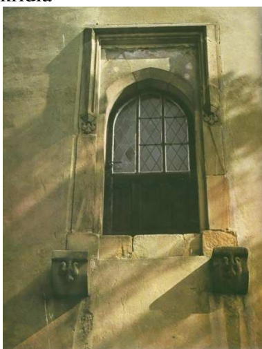
Obr. č. 68 – dveře do horních prostor obytné věže
