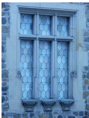
Obr. č. 61 – okno v prvním patře
