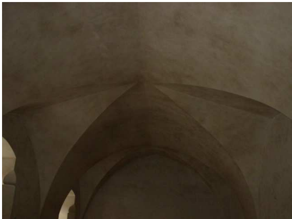
Obr. č. 117 – klenba Rytířského sálu
