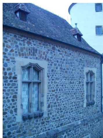
Obr. č. 59 – severní křídlo
