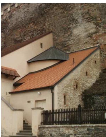
Obr. č. 13 – kabřinec na bývalé pokladně
