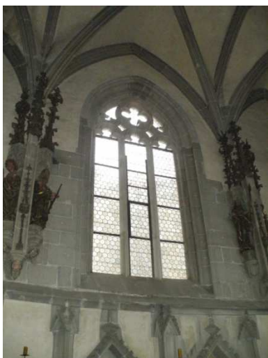
Obr. č. 84 – okno v kapli
