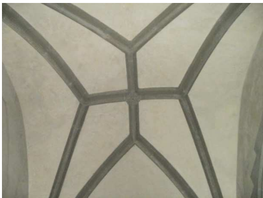
Obr. č. 72 – klenba předsíně
