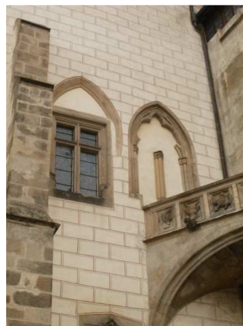
Obr. č. 48 – zazděné okno západního křídla
