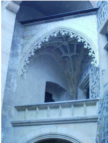
Obr. č. 53 – přechod mezi západním a severním křídlem
