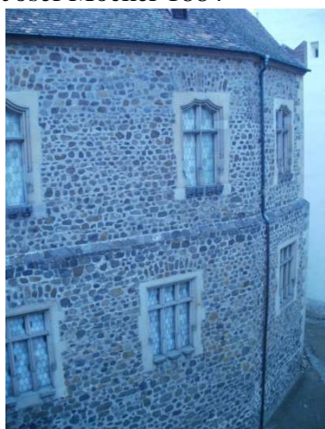
Obr. č. 60 - severní křídlo
