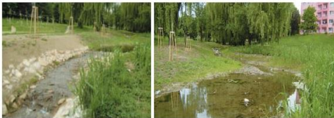
Obr. 2 a), b): Fotografie Vinohradského potoka po revitalizaci: a) úprava břehu vysvahováním, vegetační úpravy a členité dno toku ve formě kamenitých kaskád, b) prodloužení koryta formou meandrů a vytvoření drobných tůň. Zdroj: REURIS, 2010
