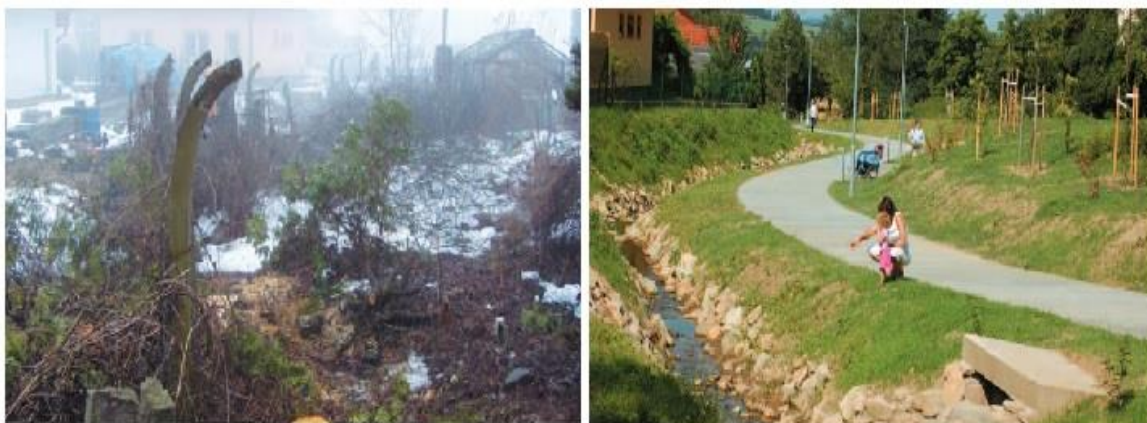
Obr. 3 a), b): Fotografie přítoku Sázavy: a) původní, zanedbaný stav oblasti, b) revitalizované koryto zpřístupněné obyvatelům včetně upravené cesty podél toku. Zdroj: REURIS, 2010
