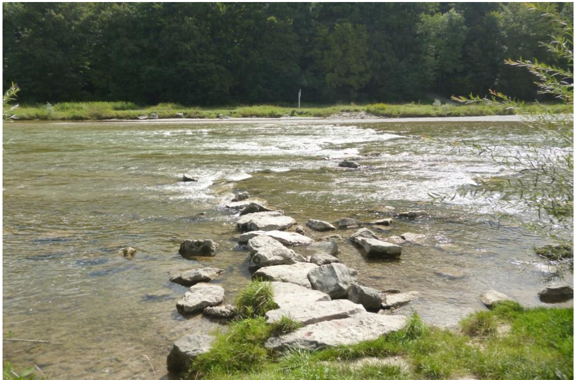
Obr. 9: Pohled na balvanité rampy, které nahradily dřívější příčné stabilizační stupně. Zdroj: Kalasová, 2016
