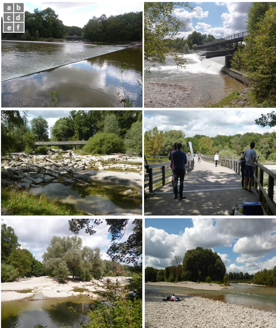
Obr. 20: Jez Flaucher: a) menší jez před Flaucherem, který je v této práci považován jako předěl mezi prvním a druhým úsekem, b) tři propouštěcí slupice v levé části celého jezu Flaucher, c) rybí přechod v pravé části jezu, kde je nižší průtok ramene řeky, v pozadí je patrný Flauchersteg, d) fotografie přímo na Flauchersteg, kde právě probíhalo reklamní focení na sportovní oblečení, e) šterkové ostrůvky a řečiště ve spodní části pravého ramene včetně mrtvého dřeva, f) pohled na propojení rozdělených ramen z jezu Flaucher. Zdroj: Kalasová, 2016
