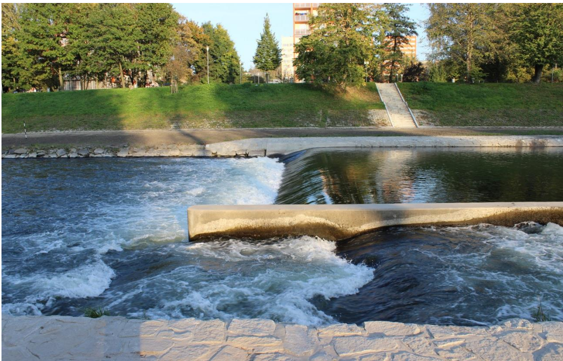
Obr. 4: Nově vybudovaný nízký jez s rybím přechodem na řece Ostravici v Ostravě. Fotografie též zachycuje pohled na zpevněné břehy, které umožňují opalování a odpočinek u řeky. Zdroj: Řeky ve městech , 2016
