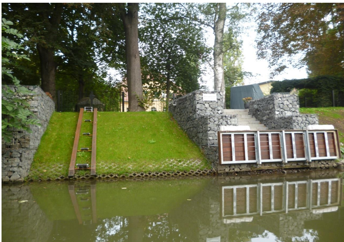
Obr. 19: Pohled na upravené břehy v Lipsku umožňující provozování plavby po vodních tocích. Zdroj: Kalasová, 2016
