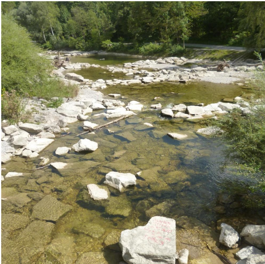
Obr. 8: Rybí přechod u jezu Flaucher tvořený kaskádou pásu z obrovských balvanů. Zdroj: Kalasová, 2016
