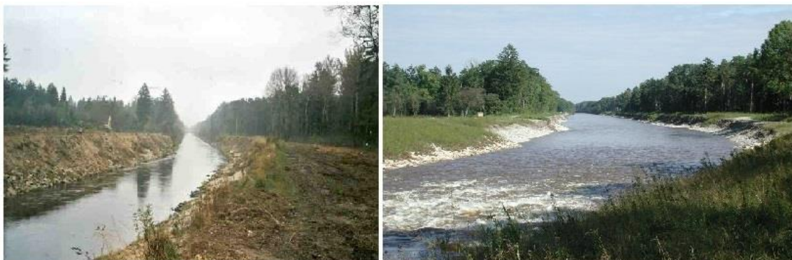
Obr. 9 a), b): Pohled na řeku mezi Inningen a Augsburgem: a) stav před revitalizací, b) rozšířené koryto řeky. Zdroj: www.wwa-don.bayern.de , 2016
