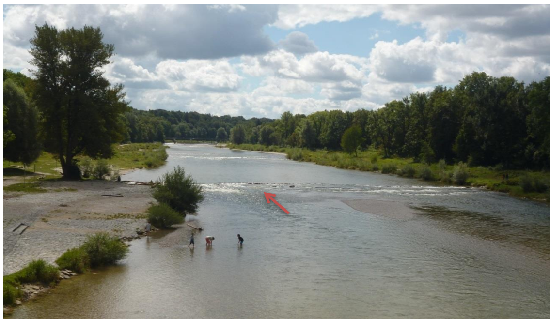
Obr. 18: Propojení několika opatření na řece Isar. Lze vidět hrubší „říční parapet“ (šipka), rozšířené koryto, možná zákoutí pro ryby podél břehů, vegetační výsadbu, která zakrývá ochranné hráze a v neposlední řadě po levé straně snímku vytvořené nábřeží vhodné k rekreaci. Zdroj: Kalasová, 2016
