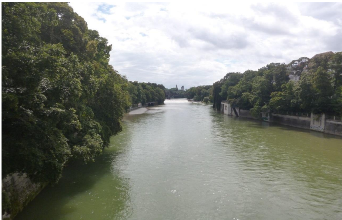
Obr. 34: Pohled na nerevitalizované koryto řeky Isar v Mnichově. Z fotografie je patrné pevné ohraničení toku betonovými zdmi. Zdroj: Kalasová, 2016
