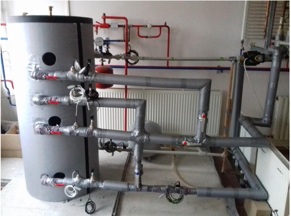
Obrázek 48: Zapojení akumulční nádoby a umístění čidel
