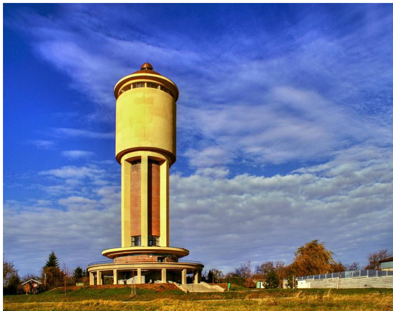
Obrázek 3 Vodárenská věž Kolín
