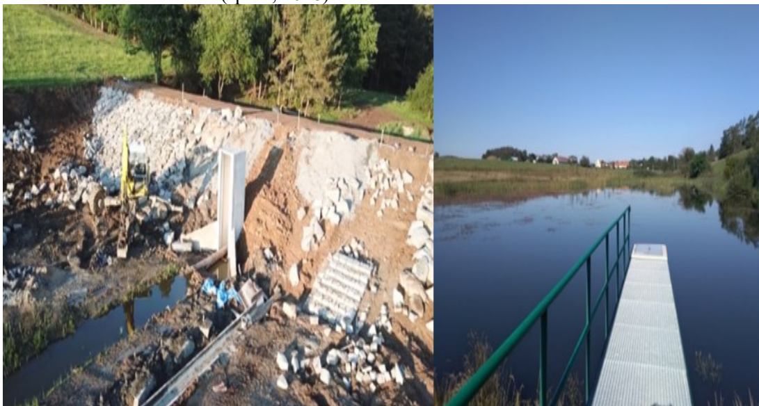
Obr. 21: Požerák s lávkou (spucr, 2018)
