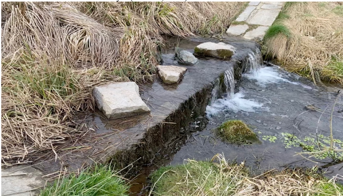
Obr. 28: Prah v obtokovém korytě (Kočová, 2023)
