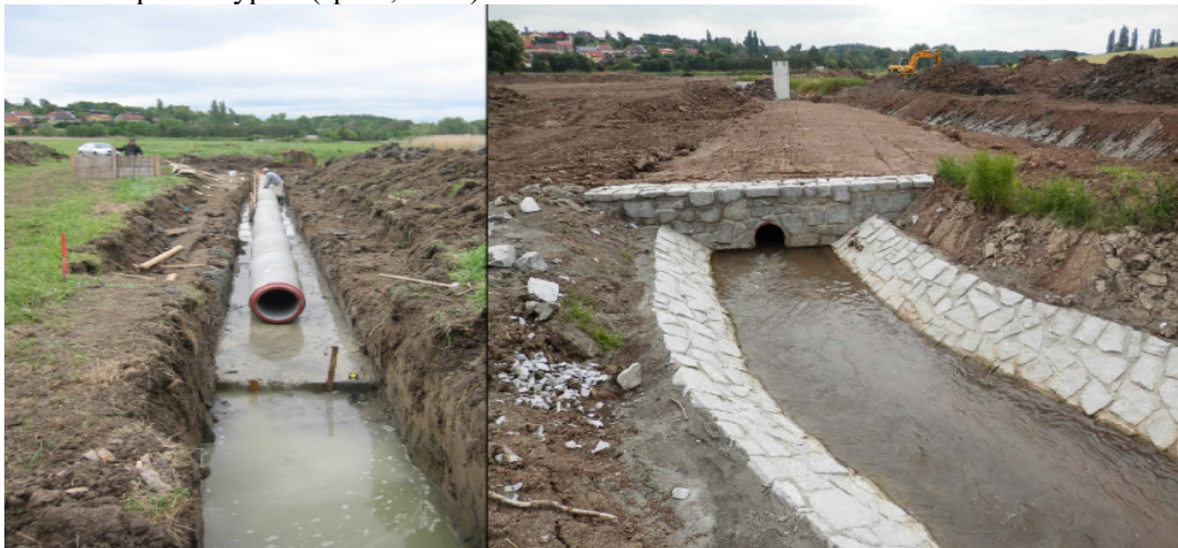
Obr. 14: Spodní výpust (spucr, 2014)
