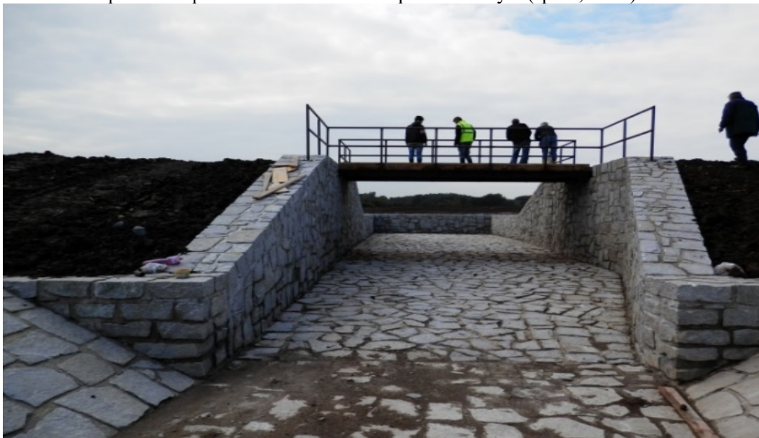
Obr. 15: Bezpečnostní přeliv s lávkou včetně odpadního koryta (spuor, 2014)
