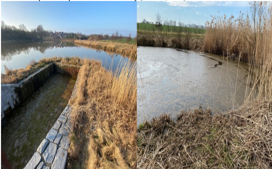
Obr. 27: Bezpečnostní přeliv a znečištění vody (Kočová, 2022)
