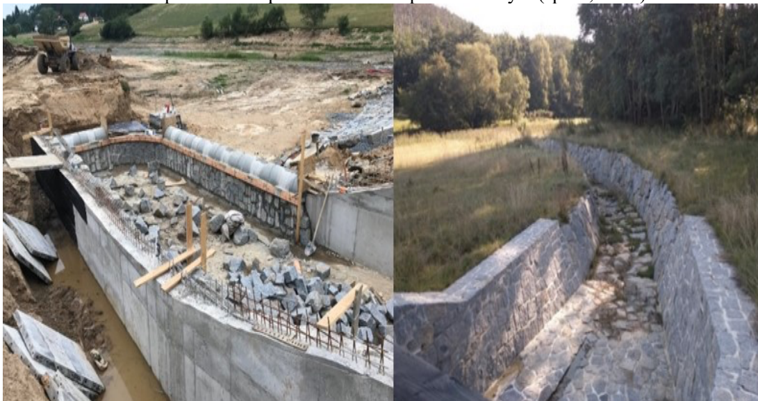
Obr. 22: Stavba bezpečnostního přelivu včetně odpadního koryta (spucr, 2018)
