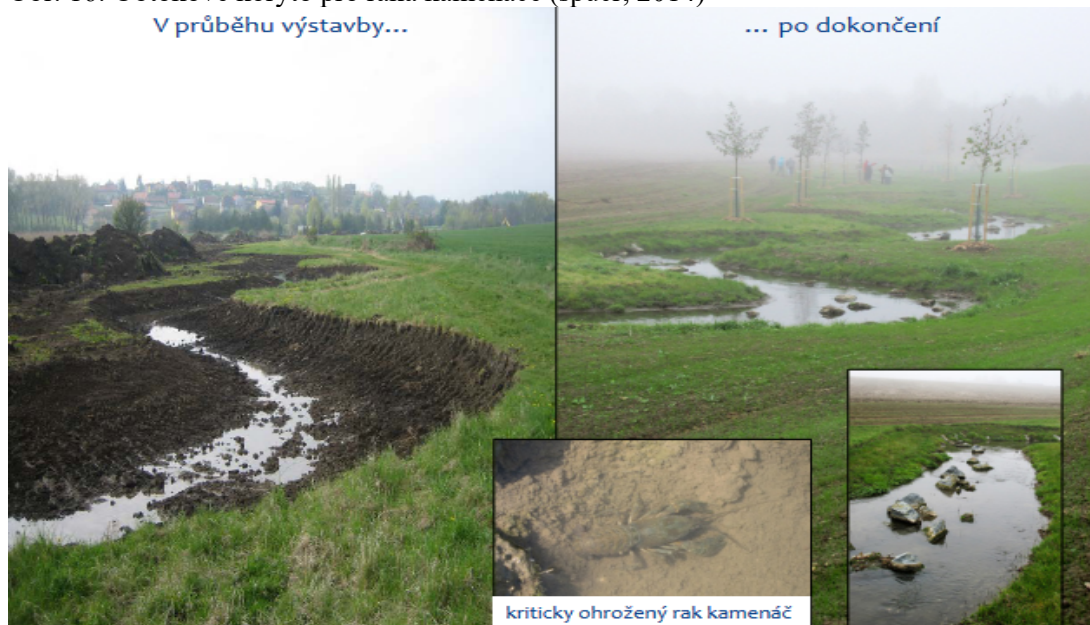
Obr. 16: Obtokové koryto pro raka kamenáče (spucr, 2014)
