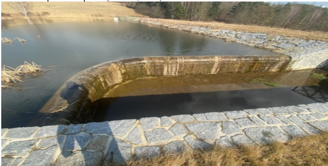
Obr. 35: Lávka včetně koryta bezpečnostního přelivu (Kočová, 2022)
