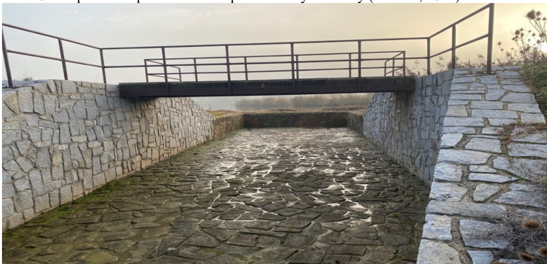
Obr. 25: Bezpečnostní přeliv včetně odpadního koryta a lávky (Kočová, 2022)
