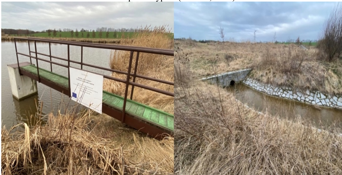
Obr. 25: Bezpečnostní přeliv včetně odpadního koryta a lávky (Kočová, 2022)
