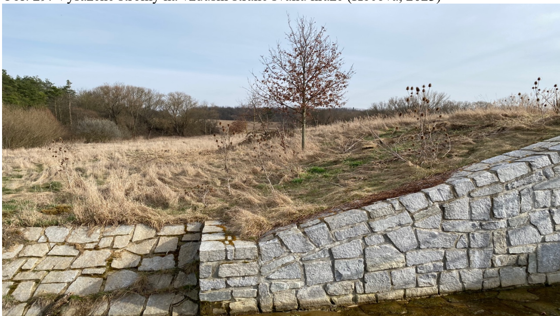
Obr. 29: Vysázené stromy na vzdušné straně svahu hráze (Kočová, 2023)
