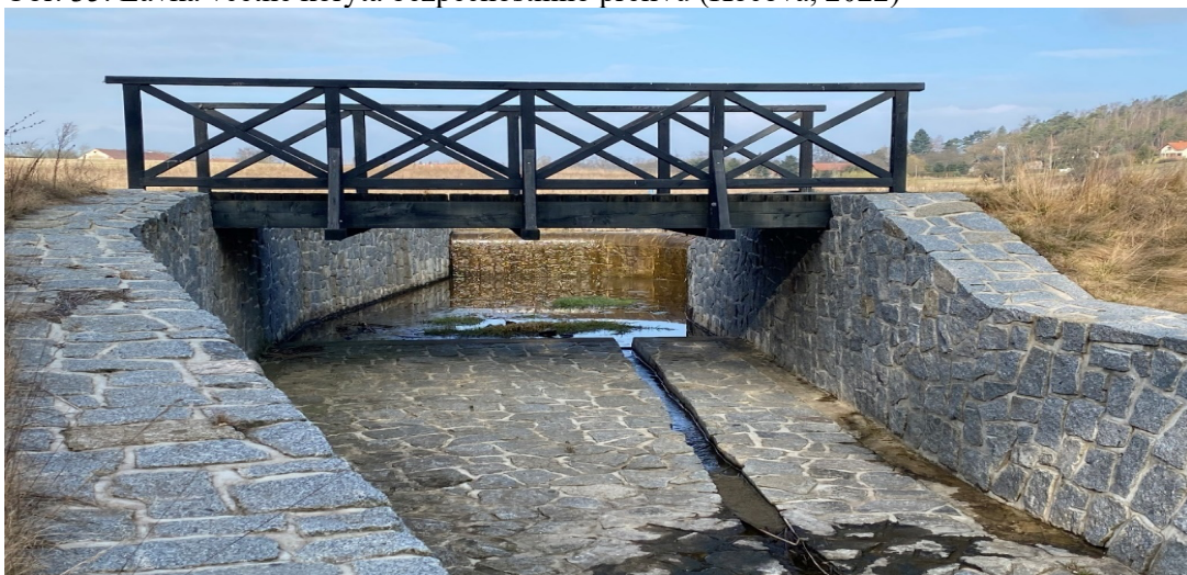
Obr. 36: Schody a požerák s lávkou (Kočová, 2022)
