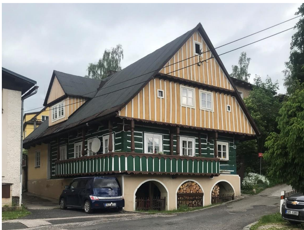
Fotografie 11: Kovárna čp. 57 ulice Bucharova, Hořejší Vrchlabí [zdroj: M. Pešková, 2020]
