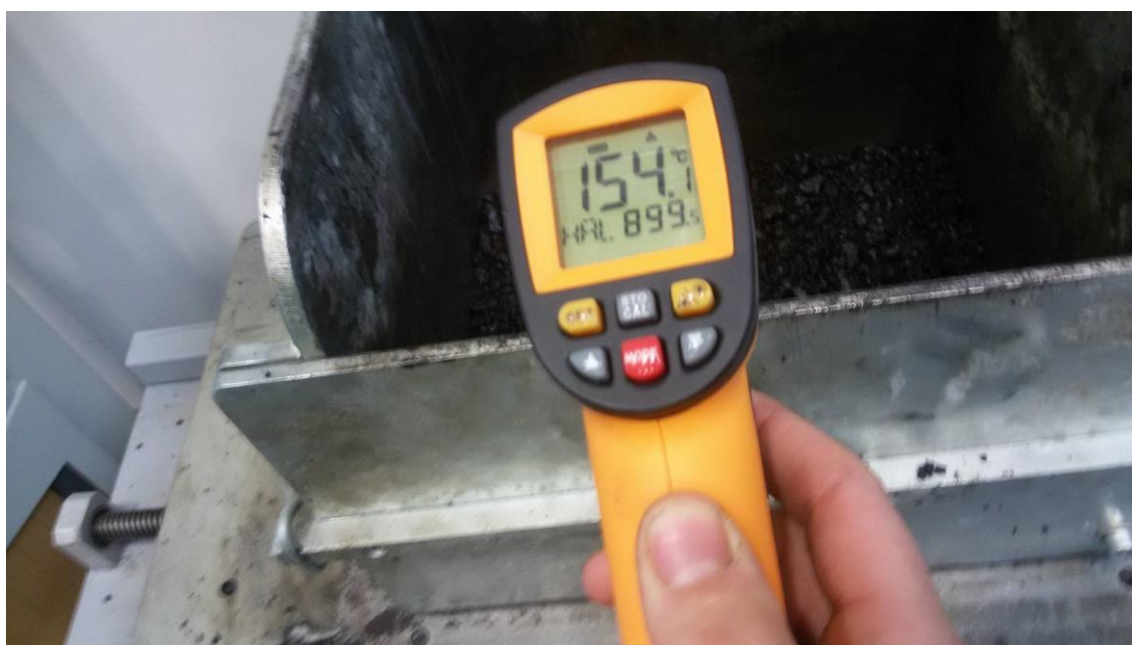
Obrázek 7: Kontrola teploty při hutnění asfaltové směsi
