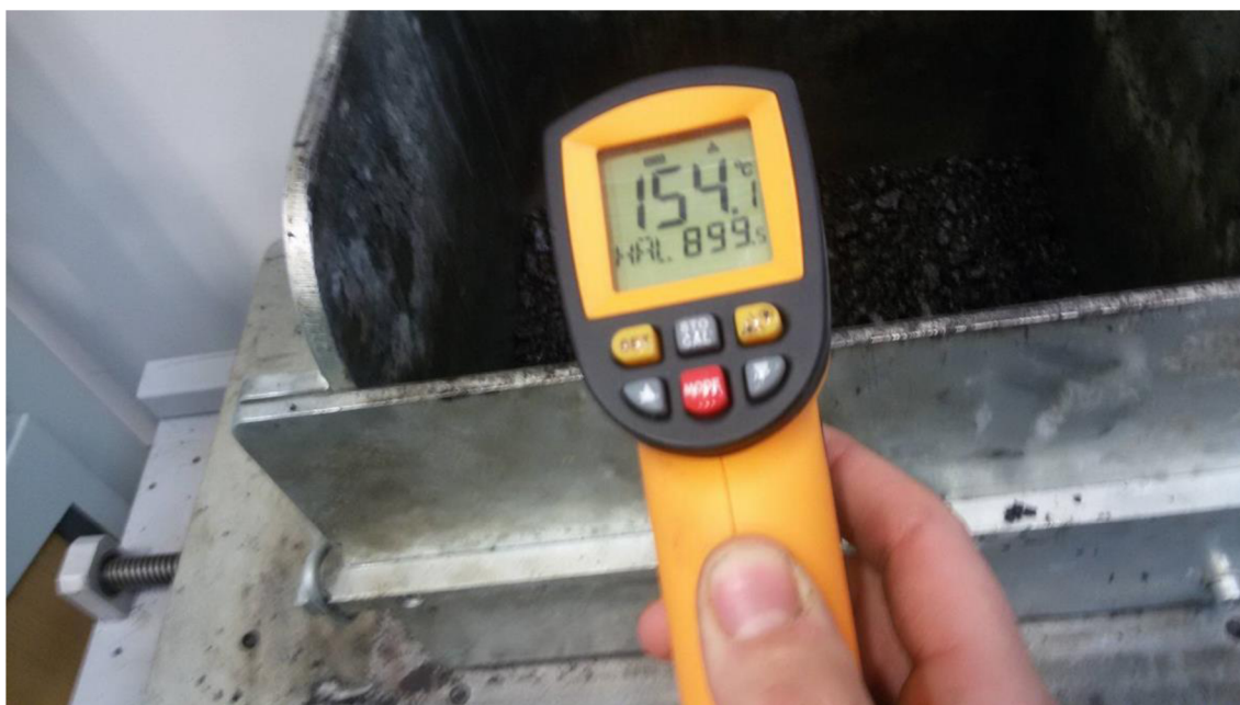
Obrázek 7: Kontrola teploty při hutnění asfaltové směsi
