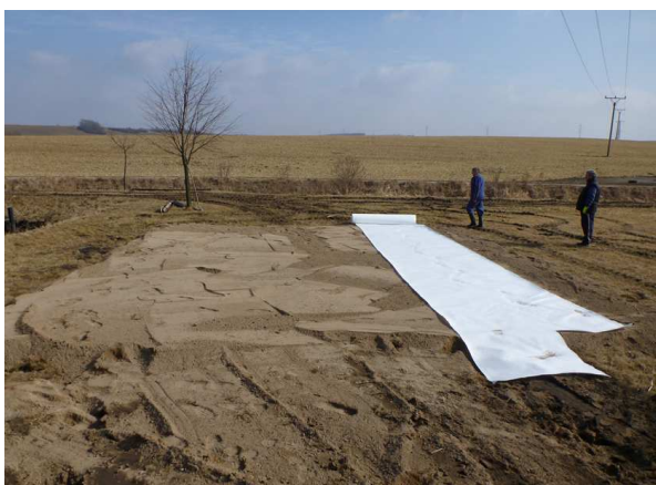
Obr. 2: Příprava podloží a skládka podkladních vrstev pod kompostem
