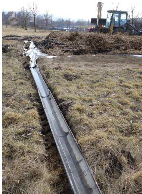
Obr. 5: Odtokový žlab pro odvod vody.
