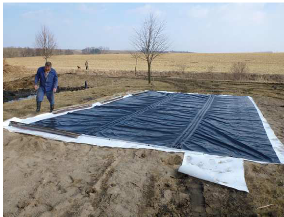
Obr. 2: Příprava podloží a skladba podkladních vrstev pod kompostem
