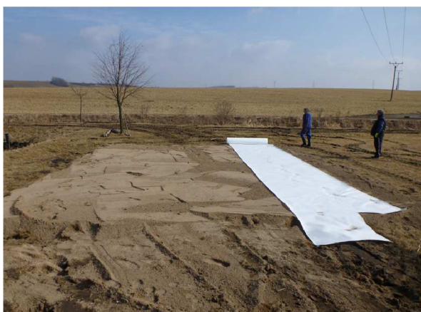
Obr. 2: Příprava podloží a skladba podkladních vrstev pod kompostem
