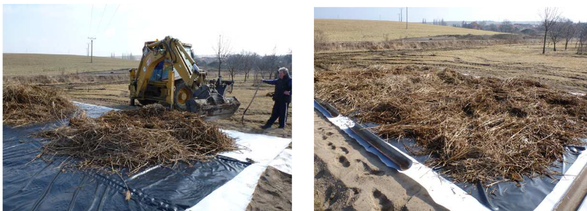
Obr. 3: První vrstva - aplikace mokřadních částí rostlin do výšky 0,5m
