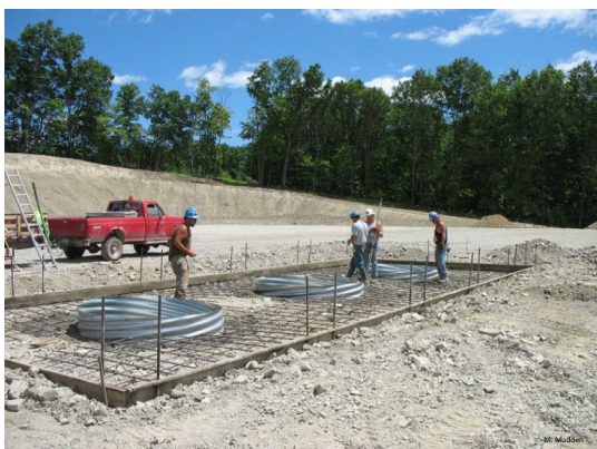
Stavba řídicích pažnicových kolon [95]
