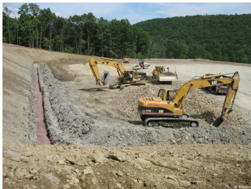
Stavba vrtné plochy [95]
