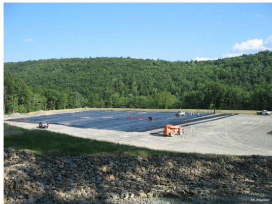
Izolace proti průsakům [95]
