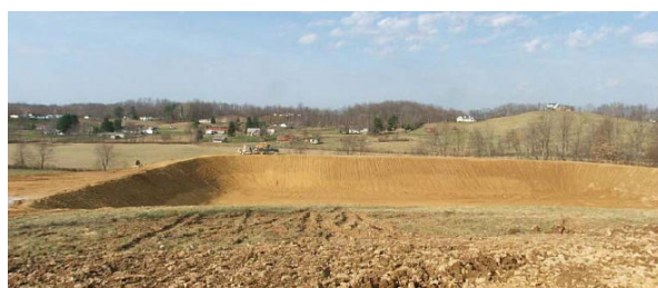
Stavba vodní nádrže [90]
