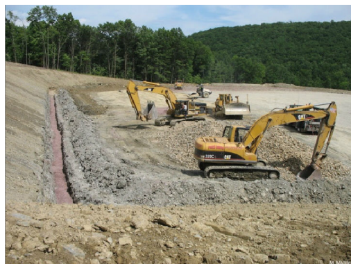
Stavba vrtné plochy [95]
