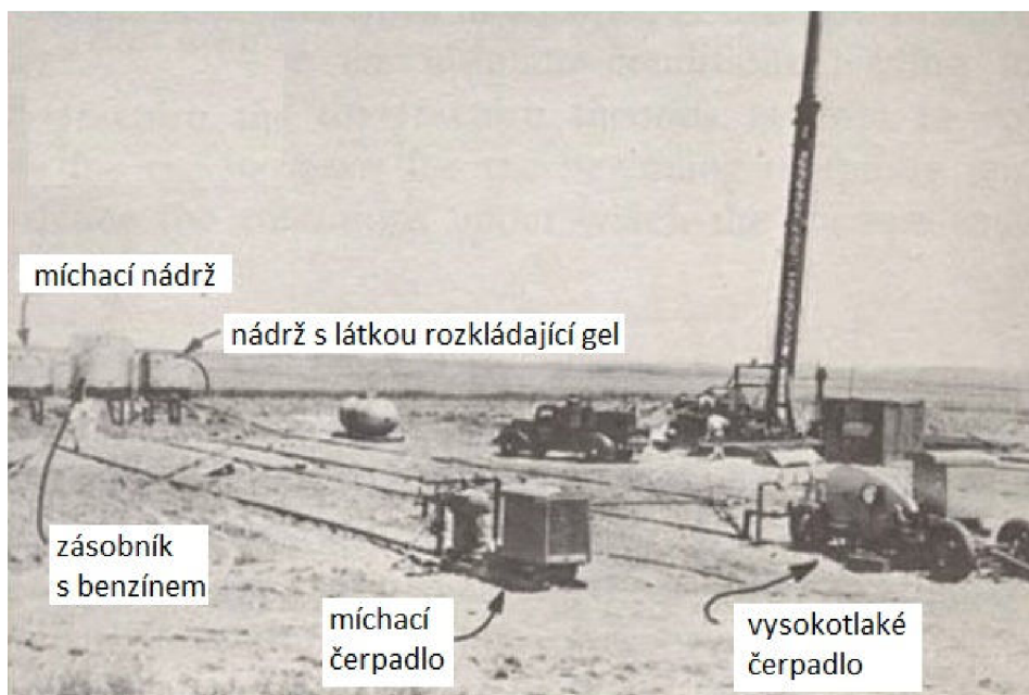
obr 3-1 První hydraulické štěpení v plynovém poli Hugoton [14]
