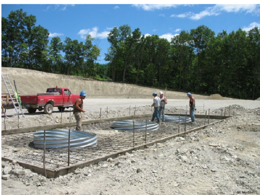
Stavba řídicích pažnicových kolon [95]
