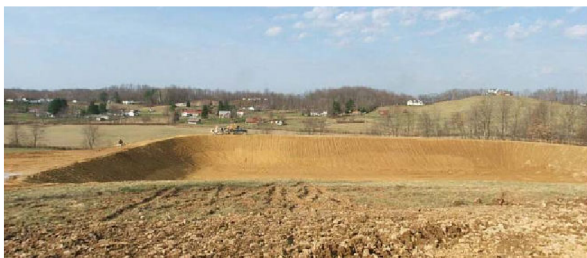
Stavba vodní nádrže [90]
