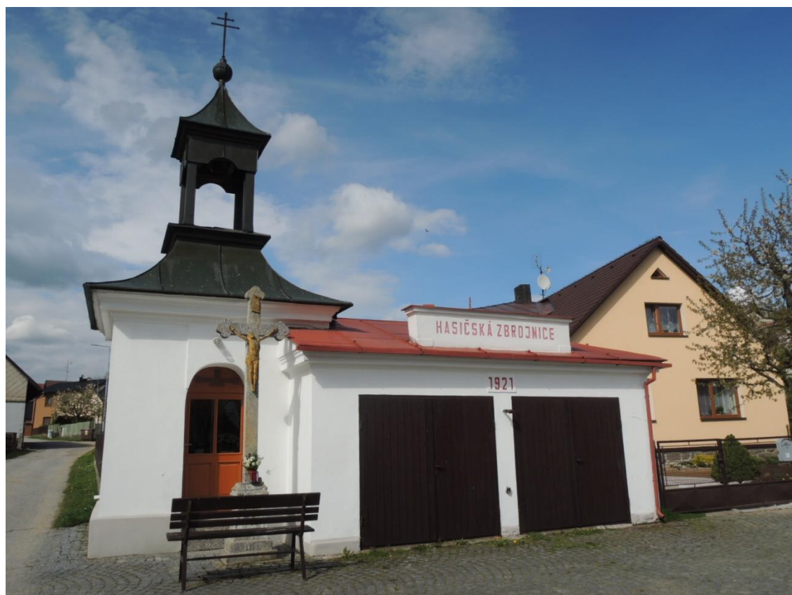
Příloha 90 Kaple na návsi v Maršovicích (vlastní archiv, 2017)
