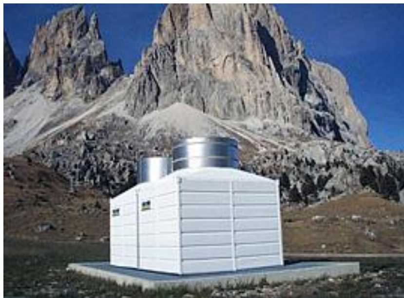
Obr. 2 Chladicí věže (zdroj www.demacsnow.cz , cit. 20. 3 .2011)
