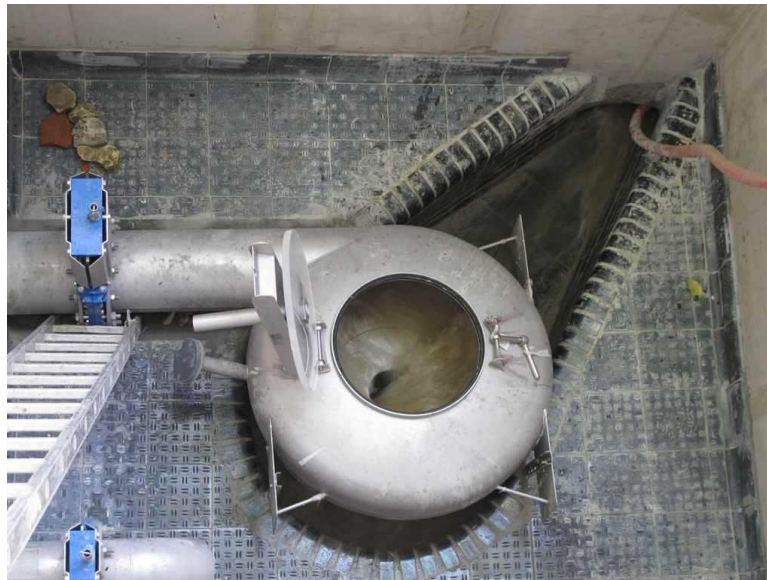
Obr. 4.3 - Vírový regulátor (Plečnickova výust') [12]
