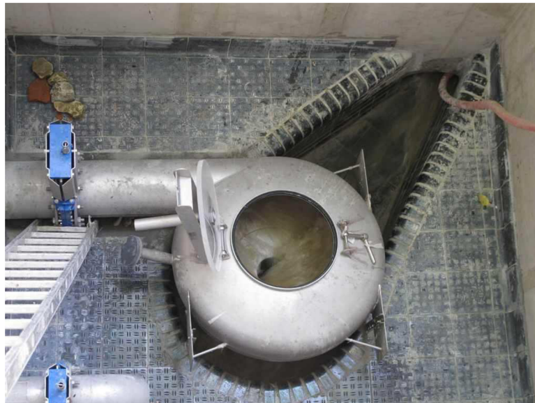
Obr. 4.3 - Vírový regulátor (Plečnickova výust') [12]
