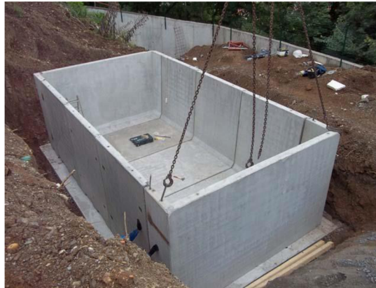
Obr. 6.2 - Podzemní prefabrikovaná betonová skládaná retenční nádrž ( V = 59,3 \text{ m}^3 ) [13]
