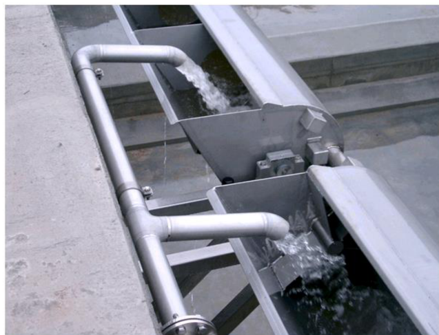
Obr. 7.1 - Plnění vyplachovací klapky [16]
