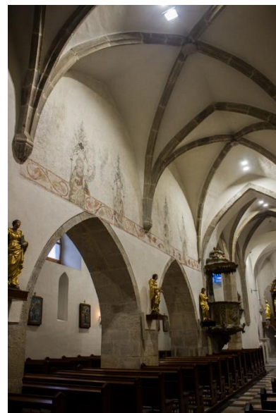
4. Pohořelice, kostel sv. Jakuba Staršího, severní stěna hlavní lodi.
