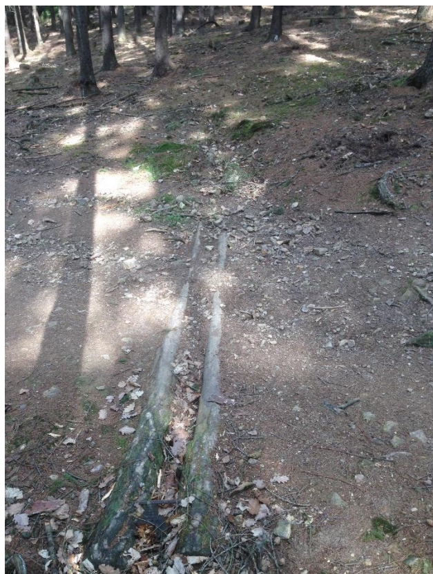
Obrázek 15: Detail svodnice na cestě 4L
