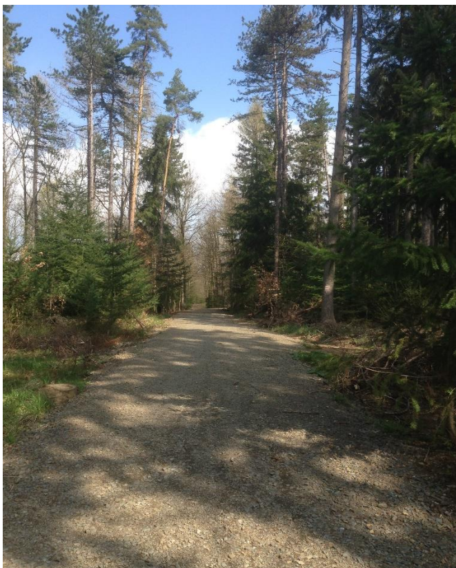
Obrázek 8: Produkční plocha nově postavené LC
