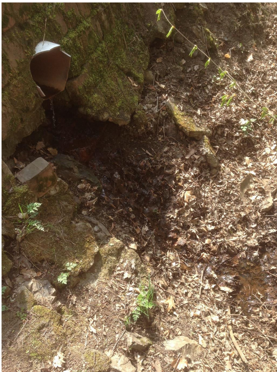
Obrázek 17: Propustek na LC 2L
