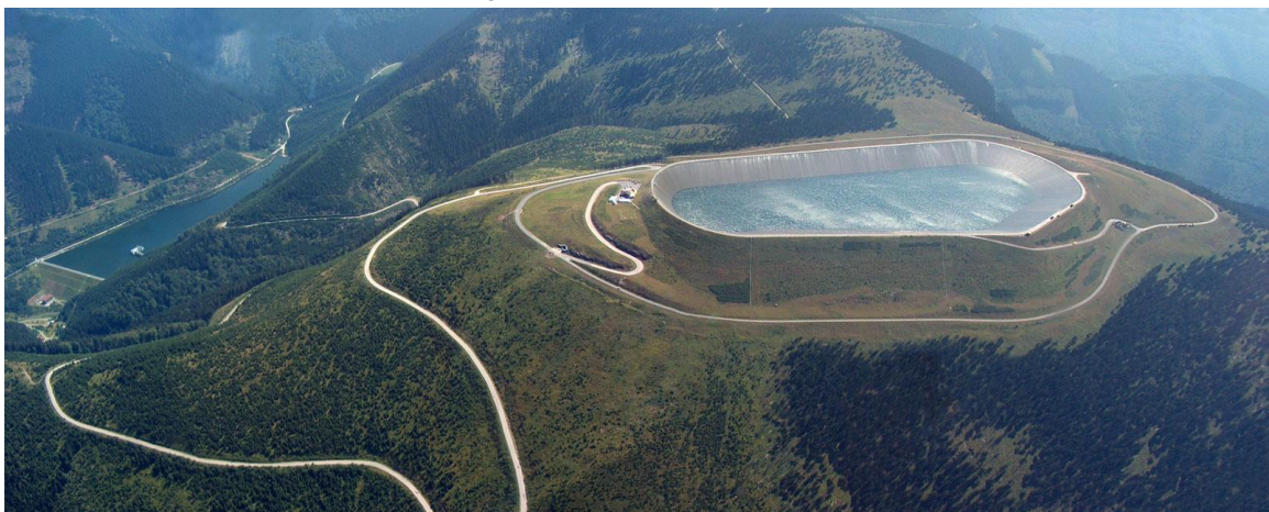
Obr. 4 - Přečerpávací vodní elektrárna Dlouhé stráně
