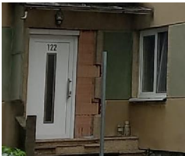
Obr. 62 Fotografie reálných dveří RD
