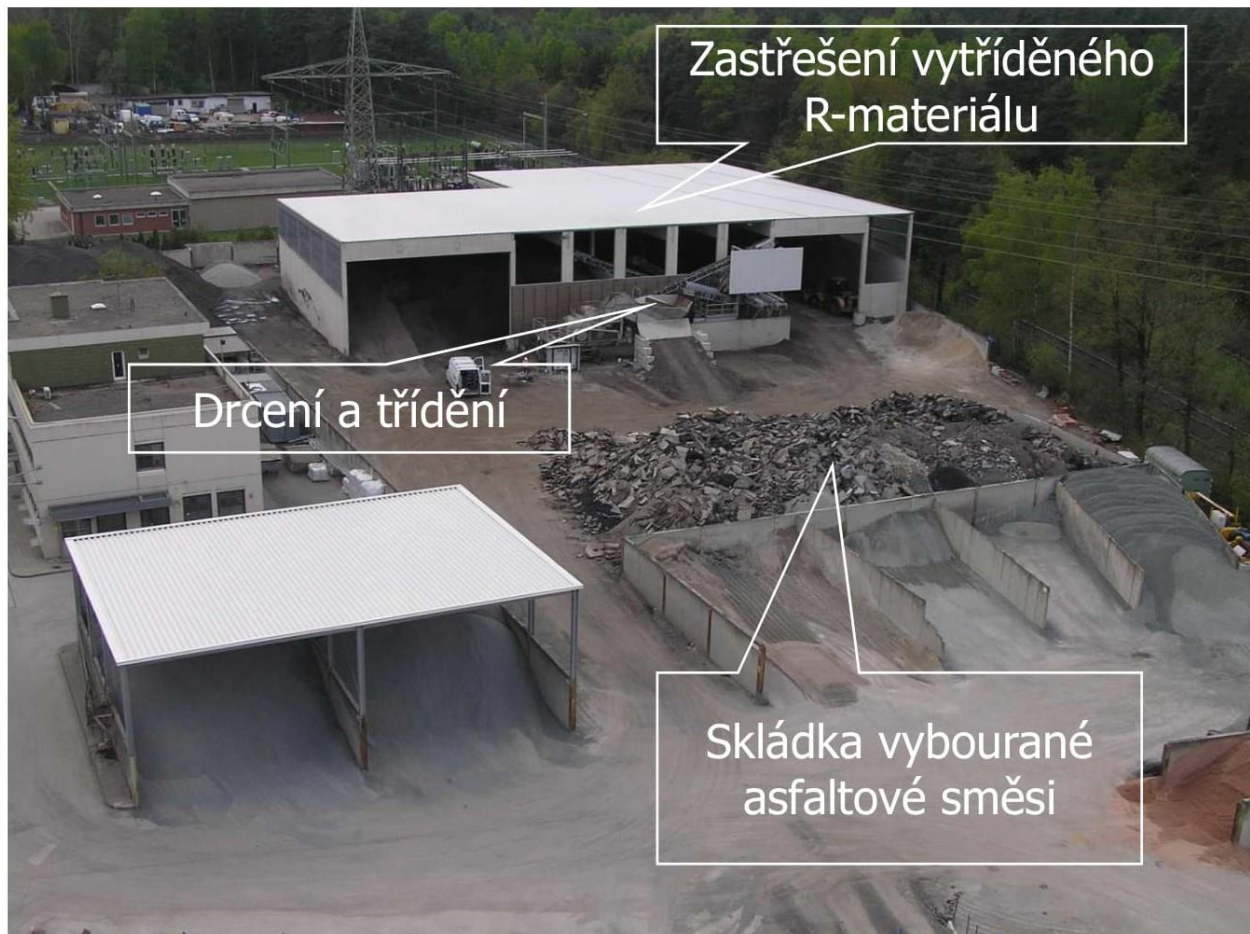
Obrázek 4 Skladování R-materiálu, drcení a třídění, zastřešení R-materiálu [9]
