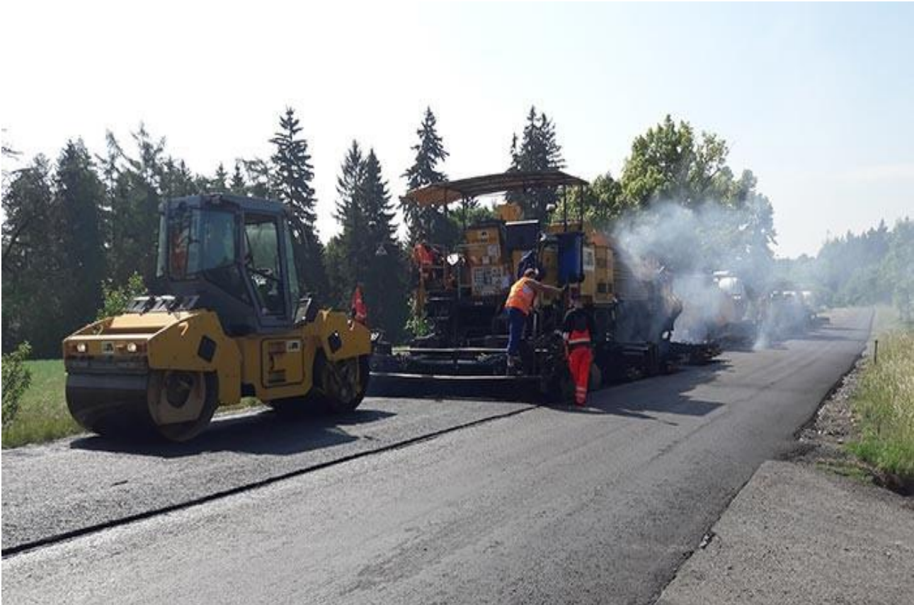
Obrázek 2 Recyklace na místě za horka (hot – in place recycling) [24]
