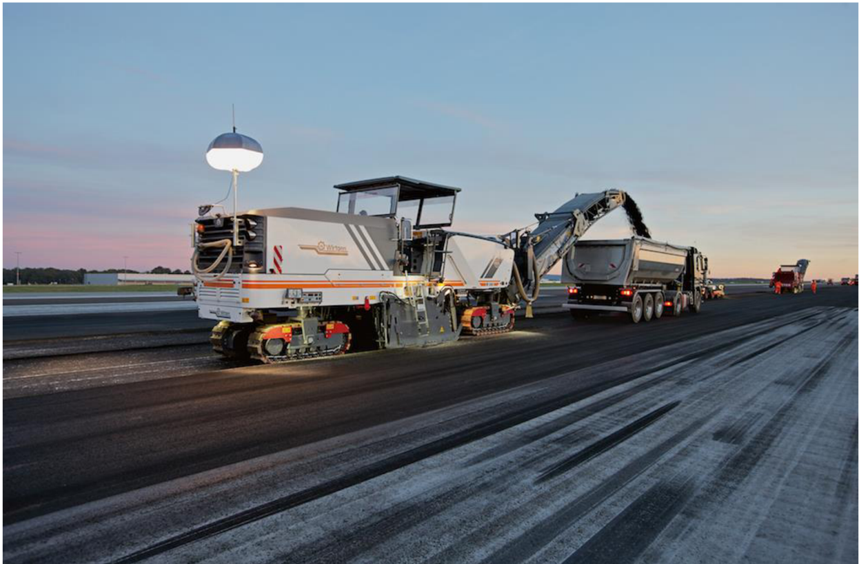
Obrázek 7 Ukázka silniční frézy při práci [25]
