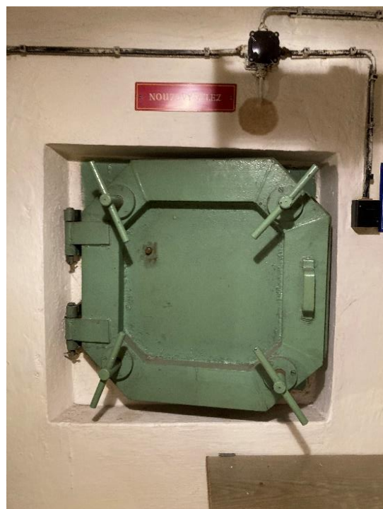
Obrázek 12. Nouzový výlez – přivřený poklop (zdroj: vlastní)
