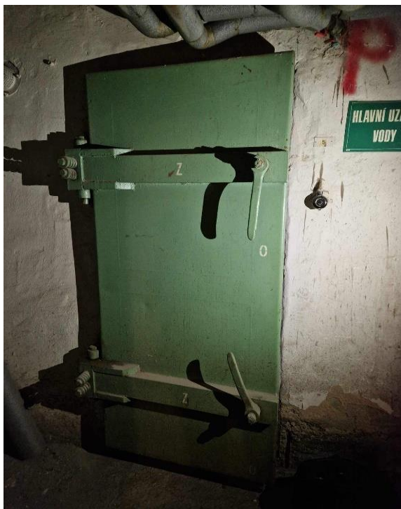
Obrázek 9. Pohled na zavřené dveře úkrytu (zdroj: vlastní)
