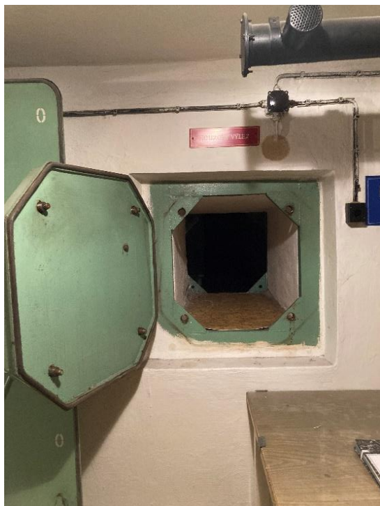
Obrázek 11. nouzový výlez z úkryt – otevřený (zdroj: vlastní)
