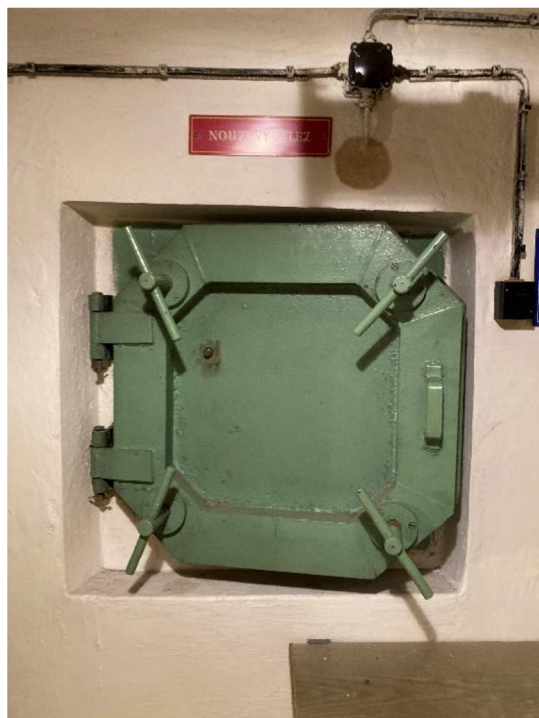
Obrázek 12. Nouzový výlez – přivřený poklop (zdroj: vlastní)
