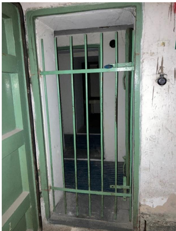
Obrázek 7. Pohled dovnitř úkrytu (zdroj: vlastní)
