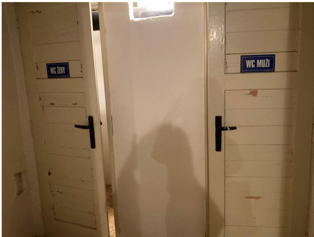
Obrázek 14. Pohled na toalety (zdroj: vlastní)
