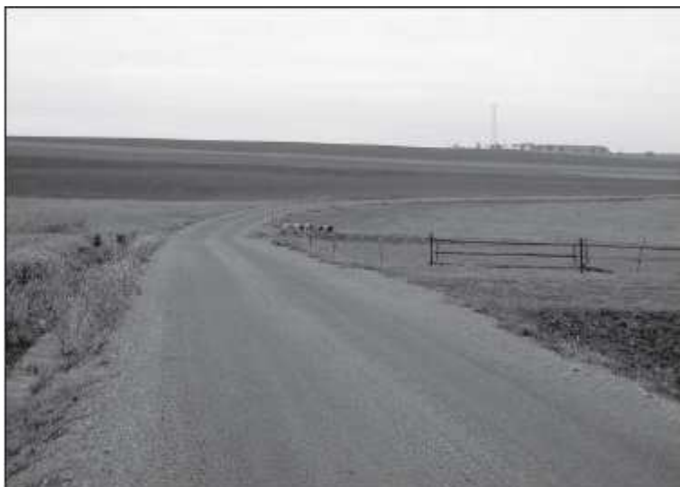
Foto č. 14 : Celkový pohled na dokončenou stavbu polní cesty C 2. 5. a C 2. 6. v katastrálním území Černíkovice u Dřevce, okr. Plzeň – sever
