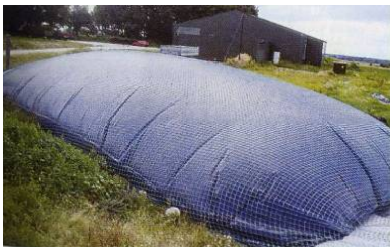
Obr. 6.3 Gumotextilní vak pro uskladnění bioplynu
