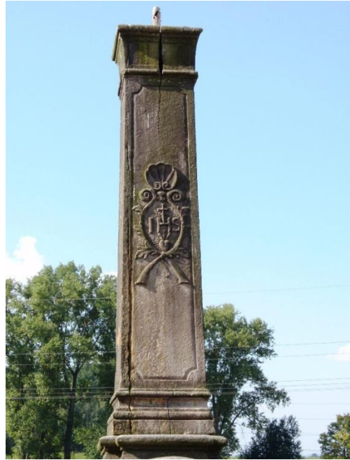
4.7.3 Detail pilíře, AA.
