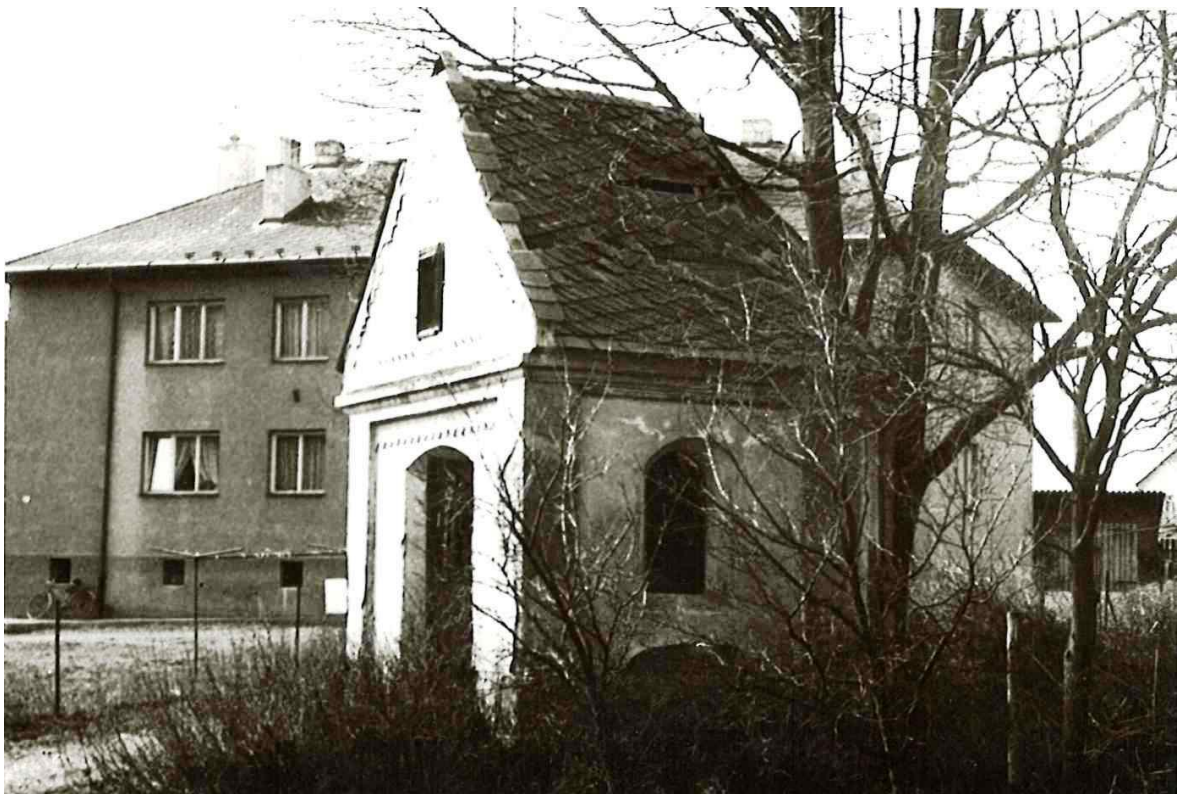
4.28.2 Výklenková kaple – boční pohled , Oldřich Kolísek.
