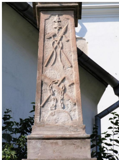
4.10.7 Detail pilíře, AA.
