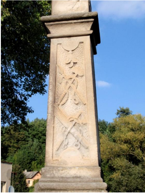
4.12.2 Detail pilíře, AA.
