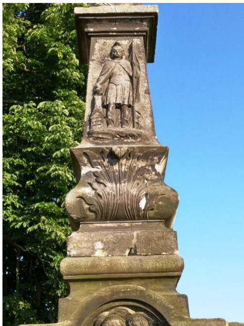
4.17.8 Detail pilíře, AA.
