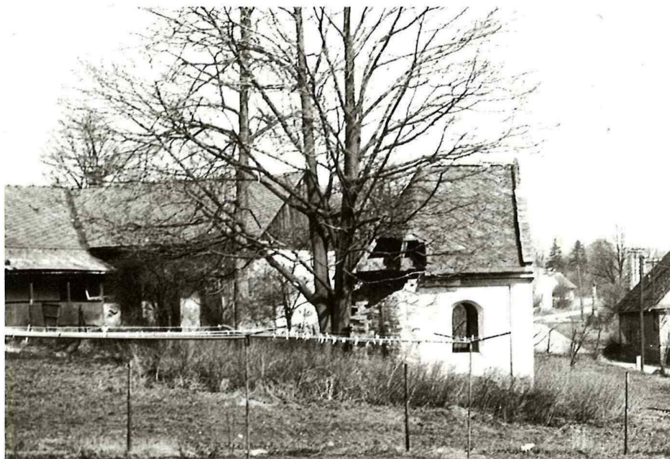
4.28.3 Vyklonková kaple – náhled poškození, Oldřich Kolísek.
