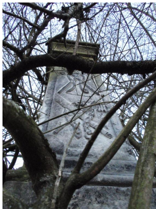
4.11.6 Detail pilíře, AA.
