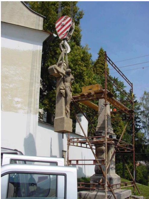
4.10.4 Průběh renovace , Oldřich Kolísek.
