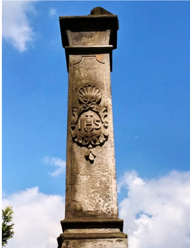
4.19.2 Detail pilíře, AA.
