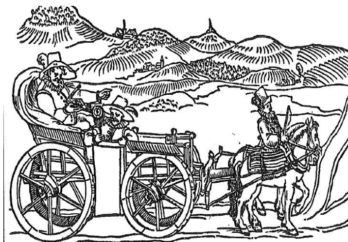
Obr. č. 1 Müllerův měřičský vůz, tzv. viatorium (Veverka a Zimová, 2008)
