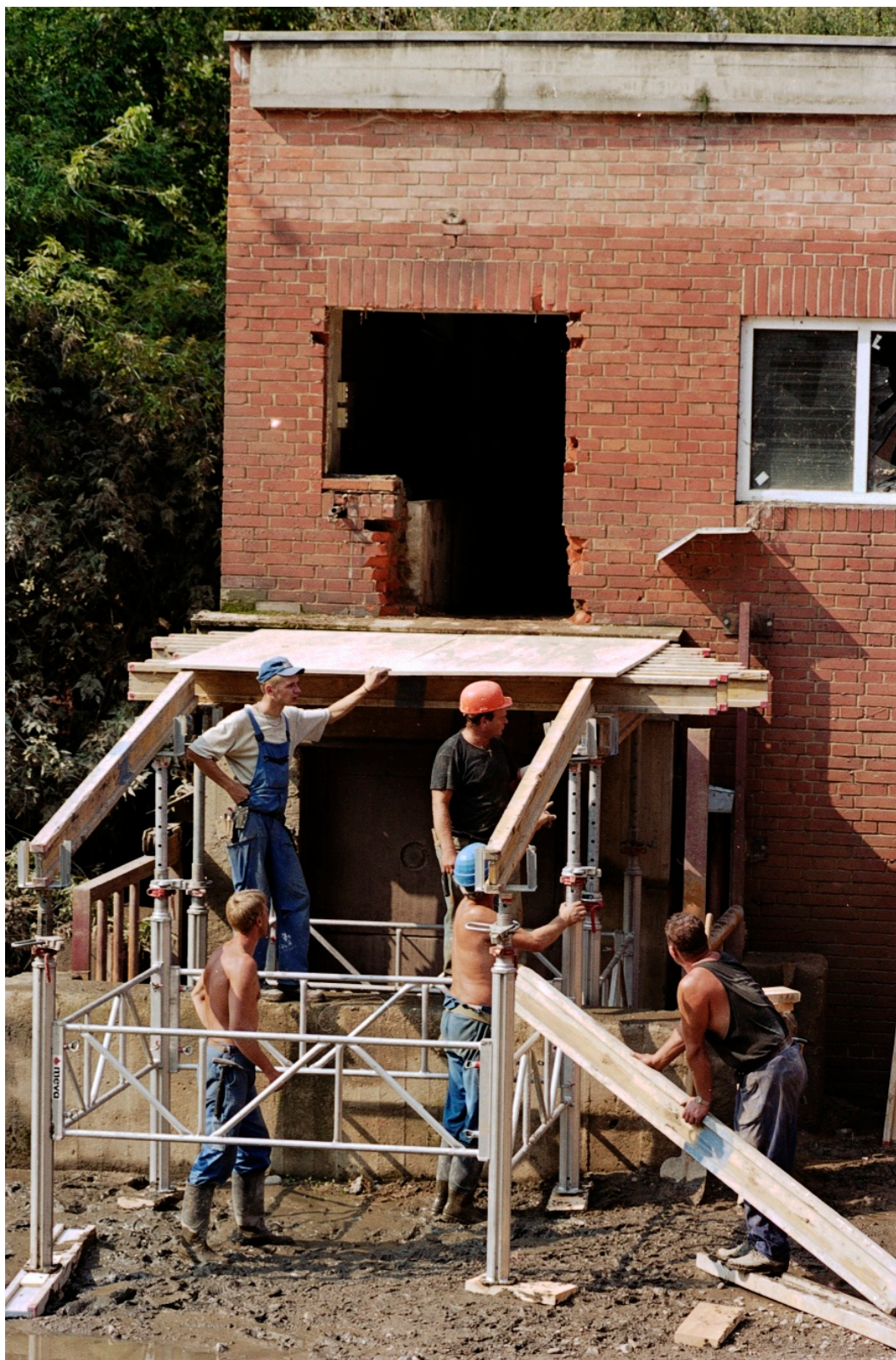
Příloha 11: Bourání a stavba otvoru pro vysvobození hrocha Slávka (Zoo Praha, 2002)
