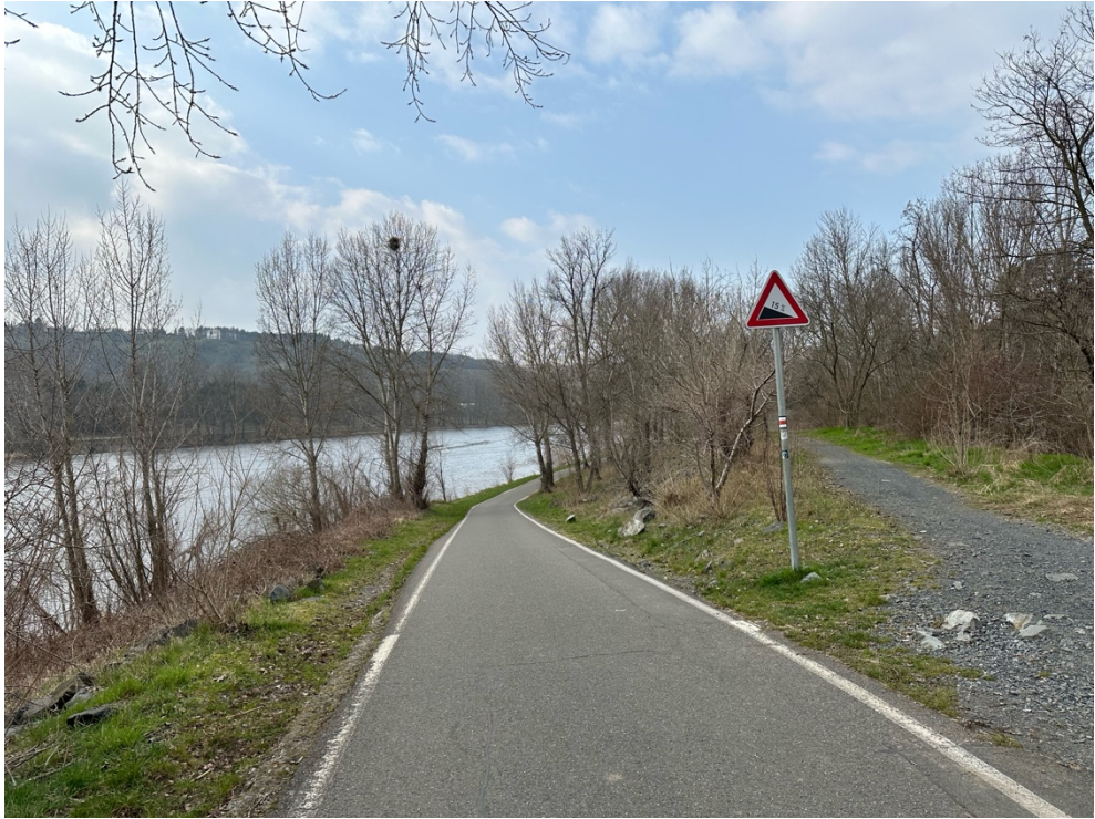
Příloha 8: Pohled na protipovodňovou hráz (Vlastní, 2024)
