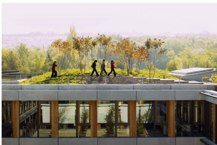
Obr. 9 – Pohled na střechu ústředí ČSOB, Zdroj – www.csob.cz
