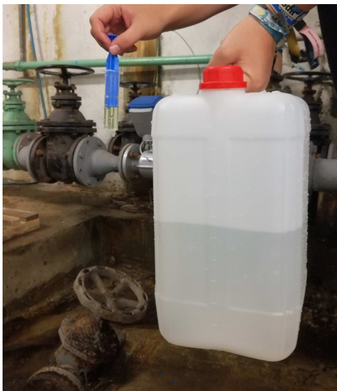
Obrázek 6 Odebrání vody z vodojemu do kanystru a místního chlornanu sodného do 20ml injekce
