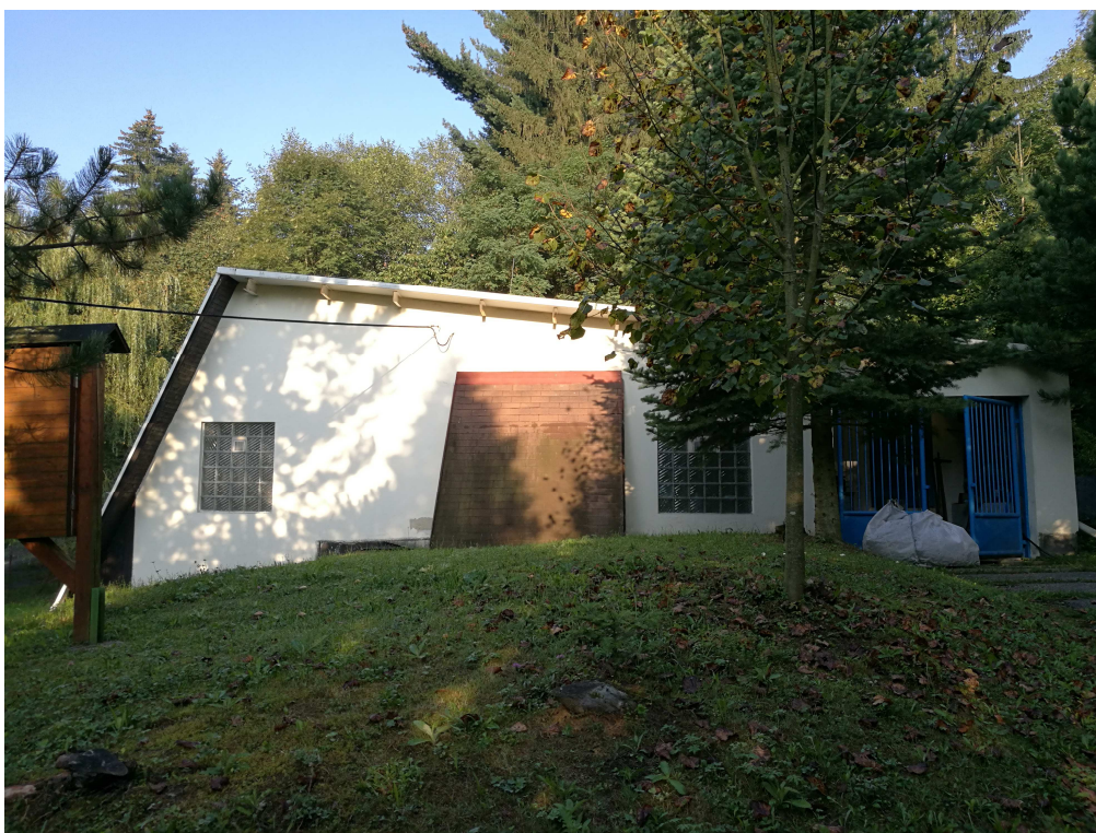
Obrázek 5 Vodojem v Kateřinicích
