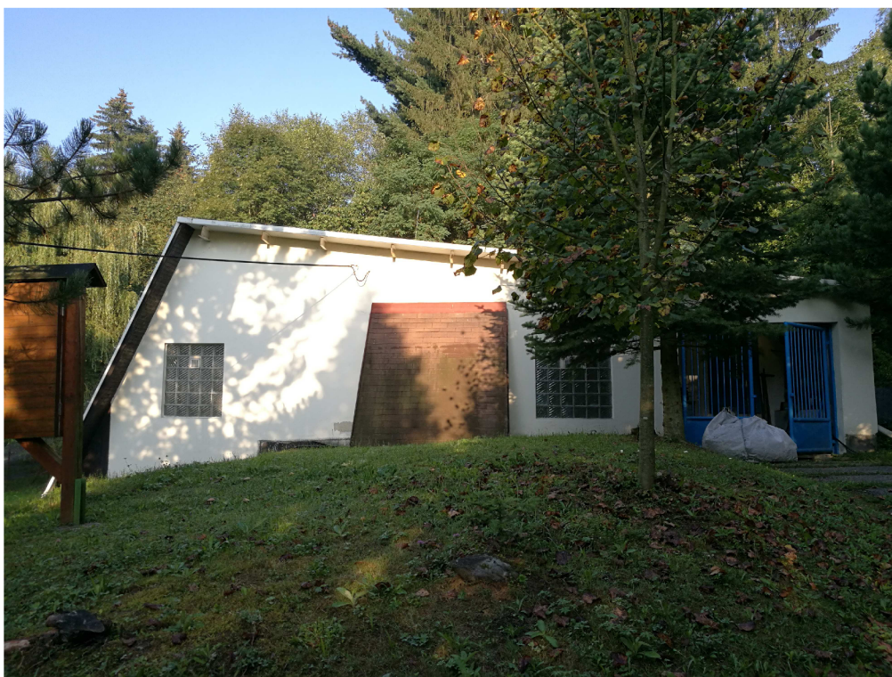
Obrázek 5 Vodojem v Kateřinicích
