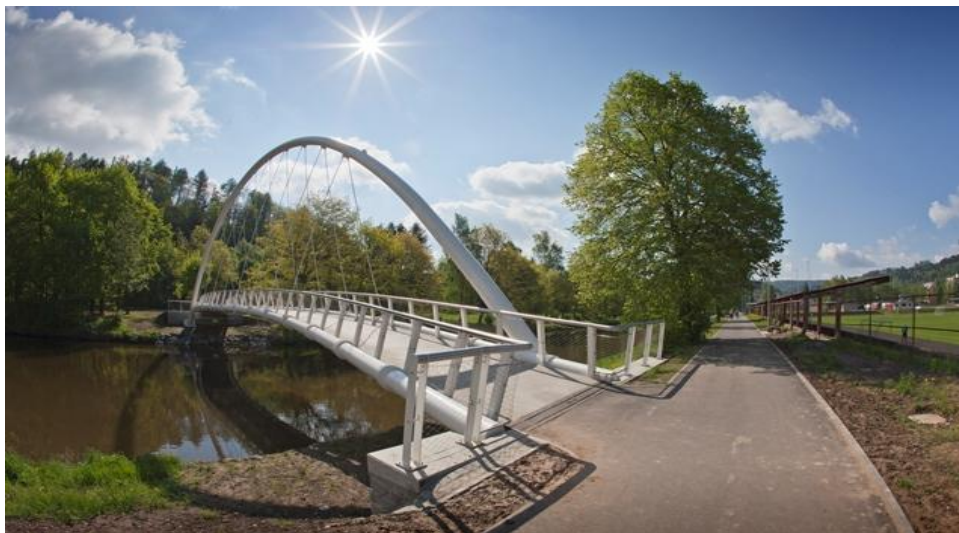
Obrázek 19 Obloukový most přes řeku Jizeru (Zdroj: vlastní)
