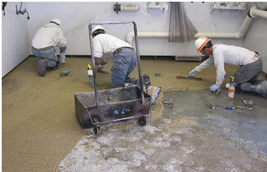
Obr. 35: Ruční stěrkování sanované podlahy pomocí epoxidové stěrky plněné křemičitým pískem [58]
