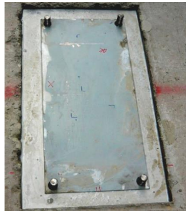
Obr. 14: Podlití ocelové základové desky (po vytvrzení zálivky) [16]
