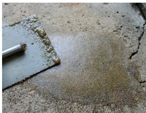
Obr. 12: Sanace zdegradovaného betonu epoxidovou správkovou hmotou [15]
