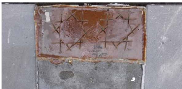
Obr. 127: Poloprovozní ověření vyvinuté zálivkové hmoty EP-Z 65% OIDM (zalité poškozené místa betonu)
