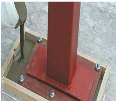
Obr. 15: Zalévání patky ocelového nosného sloupu polymercementovou zálivkou [17]
