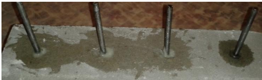
Obr. 68: Ocelové tyče zalité vyvíjenou kotvicí hmotou.
