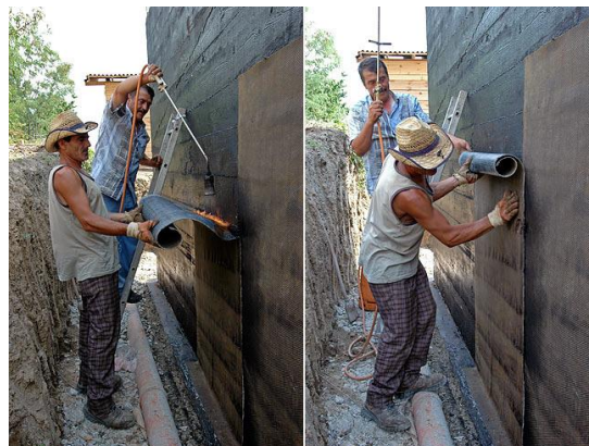
Obr. 10: Ochrana betonu bitumenovými pásy [9]
