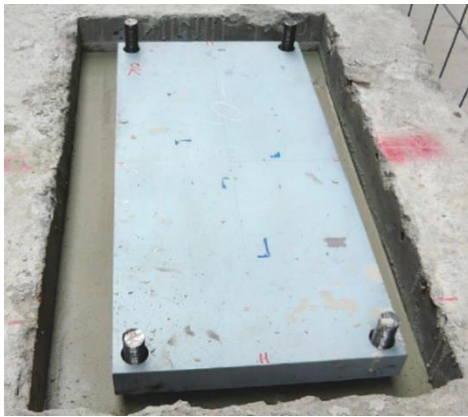
Obr. 13: Podlití ocelové základové desky polymercementovou hmotou [16]
