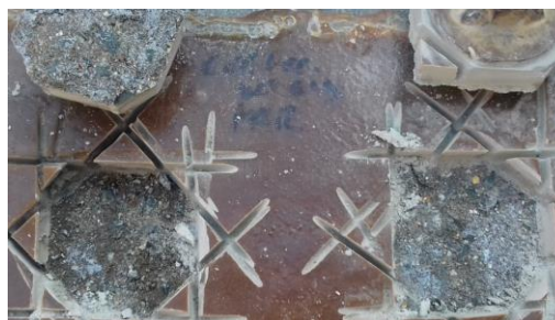
Obr. 128: Detail porušení v podkladním betonu po zkoušce soudržnosti (po 400 dnech)
