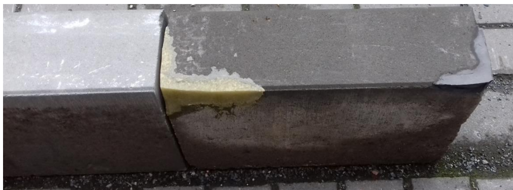
Obr. 125: Reprofilovaný obrubník po 400 dnech působení povětrnostních podmínek (období 7/2016–9/2017)
