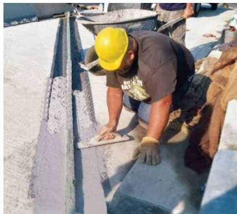
Obr. 34: Aplikace MMA polymerbetonu při sanaci mostovky [55]
