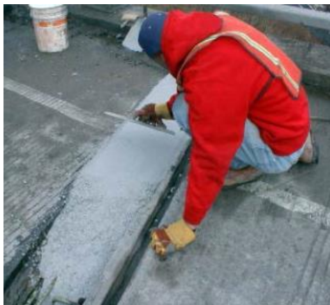
Obr. 33: Aplikace MMA polymerbetonu při sanaci mostovky [55]
