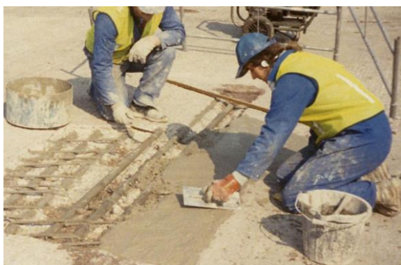
Obr. 11: Reprofilace poškozeného železobetonu polymercementovou správkovou hmotou [14]
