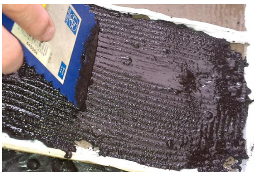
Obr. 64: Nanášení hmoty EP-S 80% SP na cementotřískovou desku pomocí zubové stěrky
