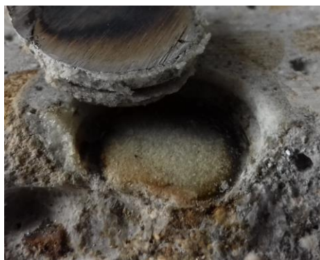
Obr. 71: Sedimentace plniva na dně otvoru, kde byla zakotvěná ocelová závitová tyč (EP-K + 60% OS)
