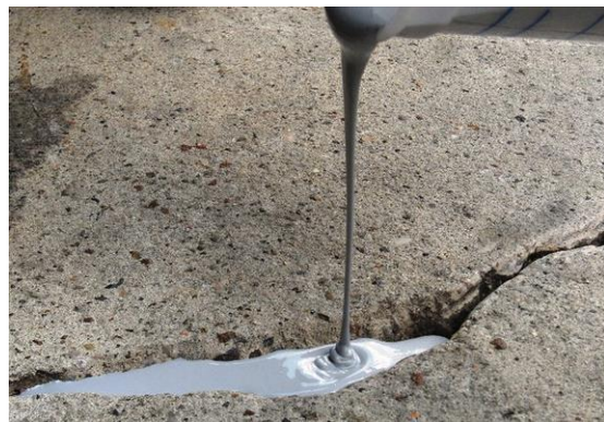
Obr. 16: Zalévání trhliny v betonu epoxidovou zálivkou [18]
