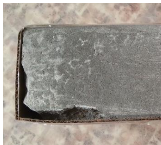
Obr. 122: Bednění vytvořené za účelem reprofilace betonového obrubníku
