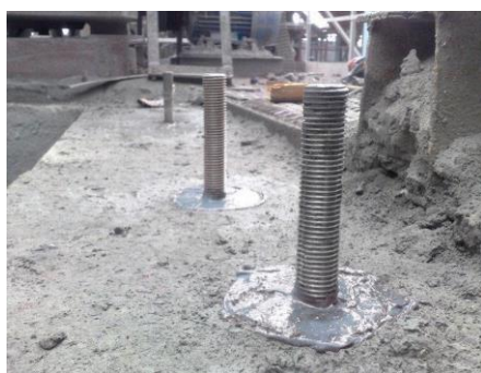
Obr. 19: Závitové tyče zakotvené pomocí chemické kotvy na bázi EP, připravené pro uchycení těžkých zařízení [24]
