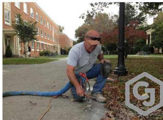
Obr. 31: PUR injektáž parní tunelové hydroizolace [53]
