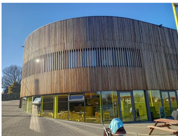
Obrázek 14 Fotka tělocvičny a MSC v Líbeznicích
