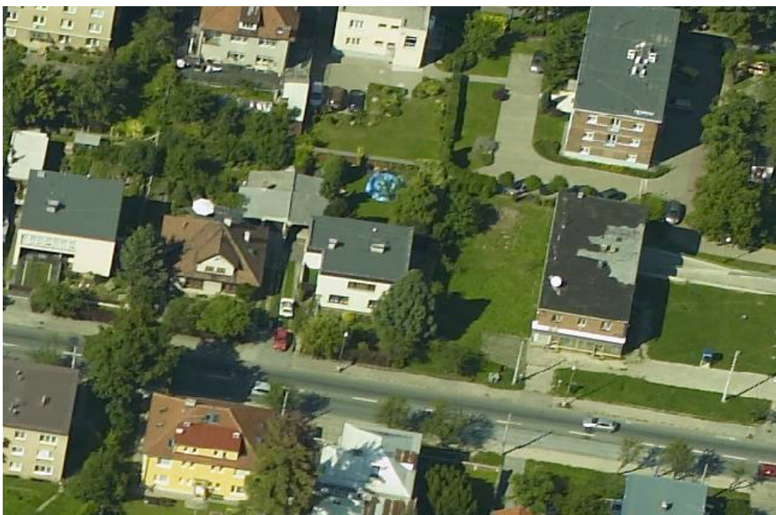
Obr. 2: Letecký pohled na prostor staveniště
