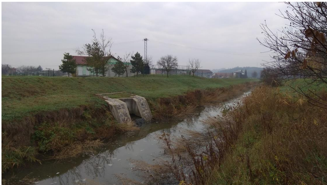
Obr. 6.7 Tok Litava – výust ČOV do recipientu – pohled proti toku
