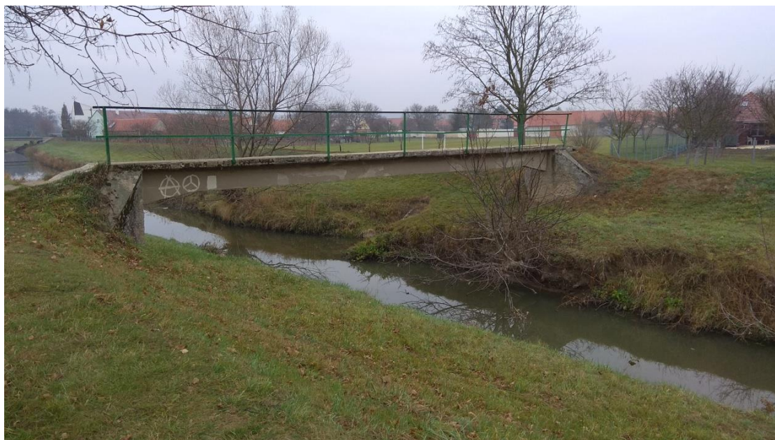
Obr. 6.11 Tok Litava – stávající lávka v ř. km 20,005 – pohled po toku
