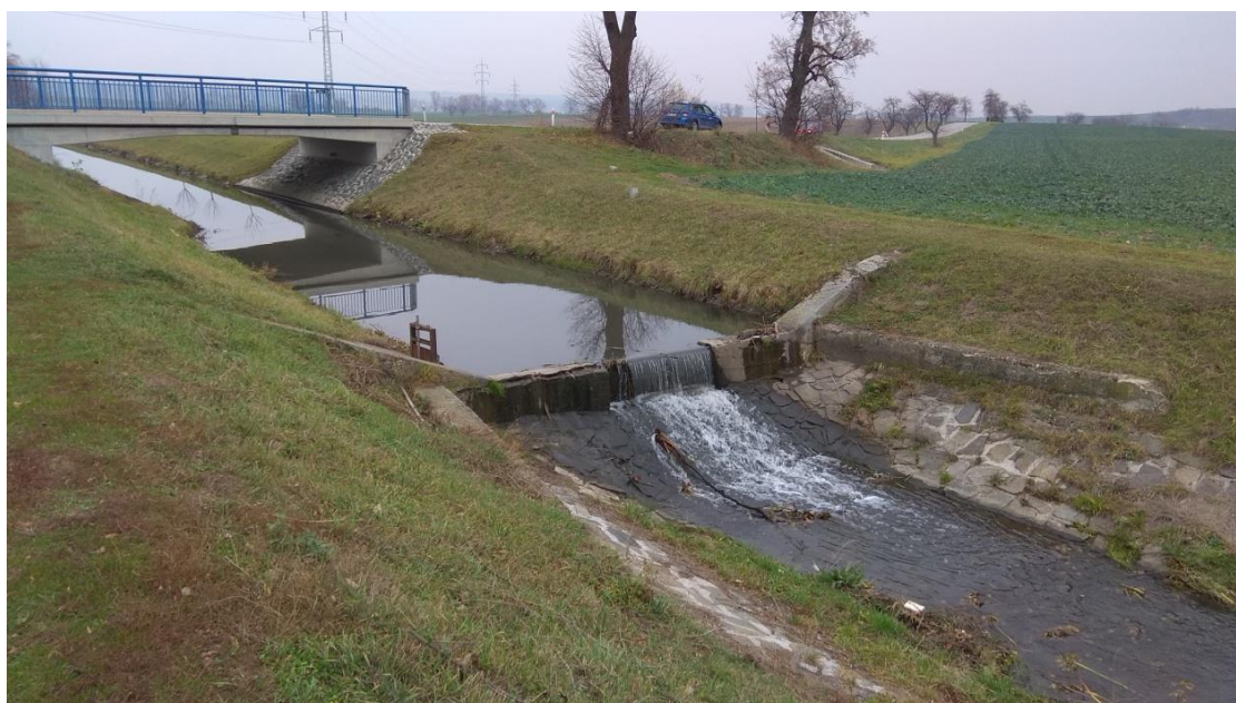
Obr. 6.15 Tok Rakovec – stávající jez v ř. km 0,264 – pohled proti toku
