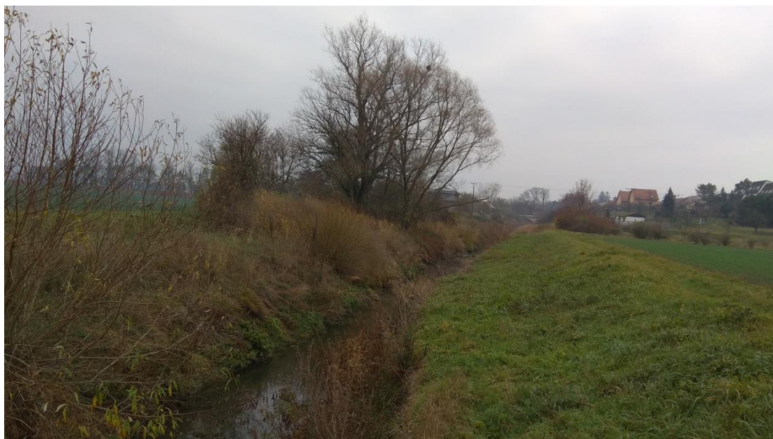
Obr. 6.13 Tok Litava – úsek koryta toku v ř. km 20,432 – 20,928 – pohled proti toku
