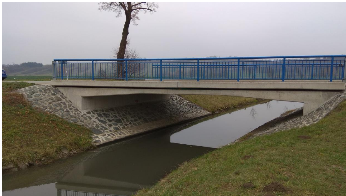
Obr. 6.14 Tok Rakovec – silniční most v ř. km 0,287 – pohled proti toku
