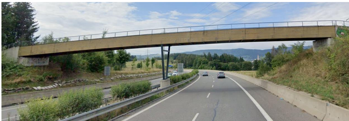
Obr. 8 - Dřevěná trámová lávka přes silnici I. třídy (zdroj: Google maps)
