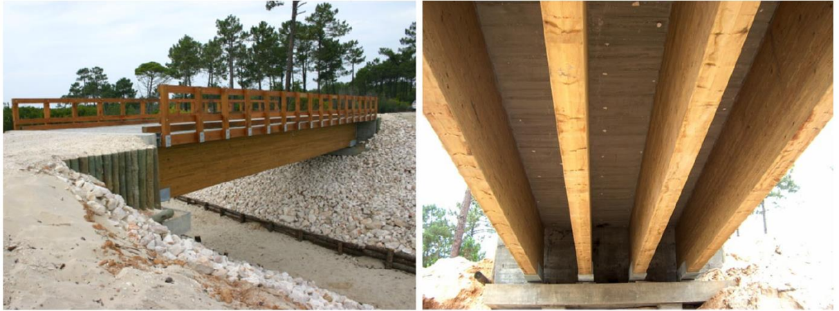
Obr. 25 - dřevo-betonový most v portugalském Quiaios. (zdroj: Fragiaco a kol., 2018)
