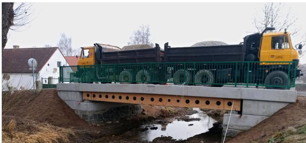
Obr. 22 - Bohunický dřevo-betonový most.
