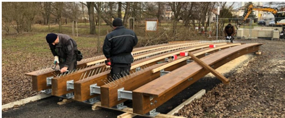
Obr. 21 - Montáž dřevo-betonové lávky na Mělníku
