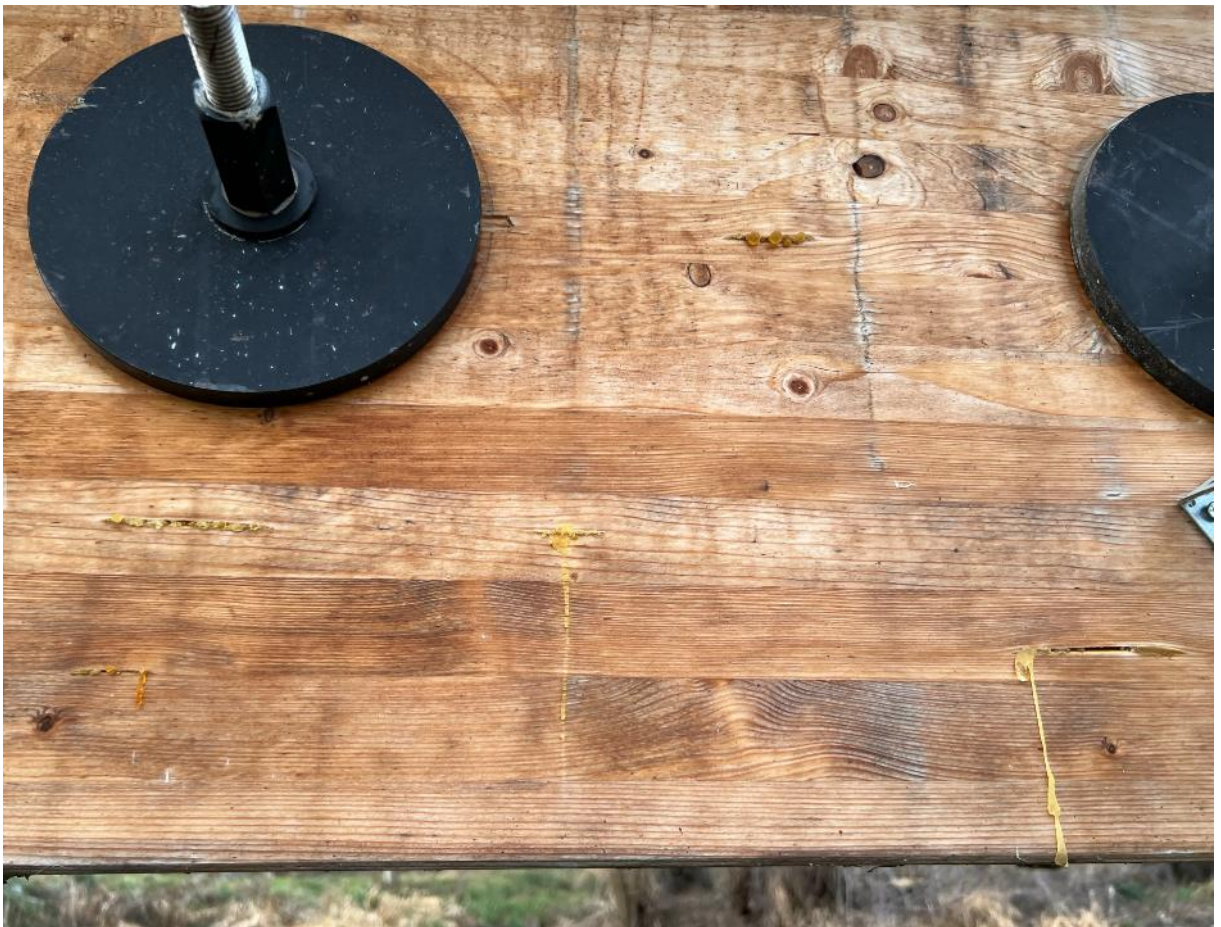
Obr. 43 - Smolníky na LLD trámech tvořící nosnou konstrukci mostu
