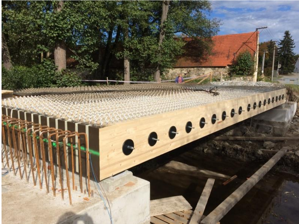
Obr. 29-dřevěná část nosné konstrukce-LLD mostovka s připravenými spřahovacími vruty
