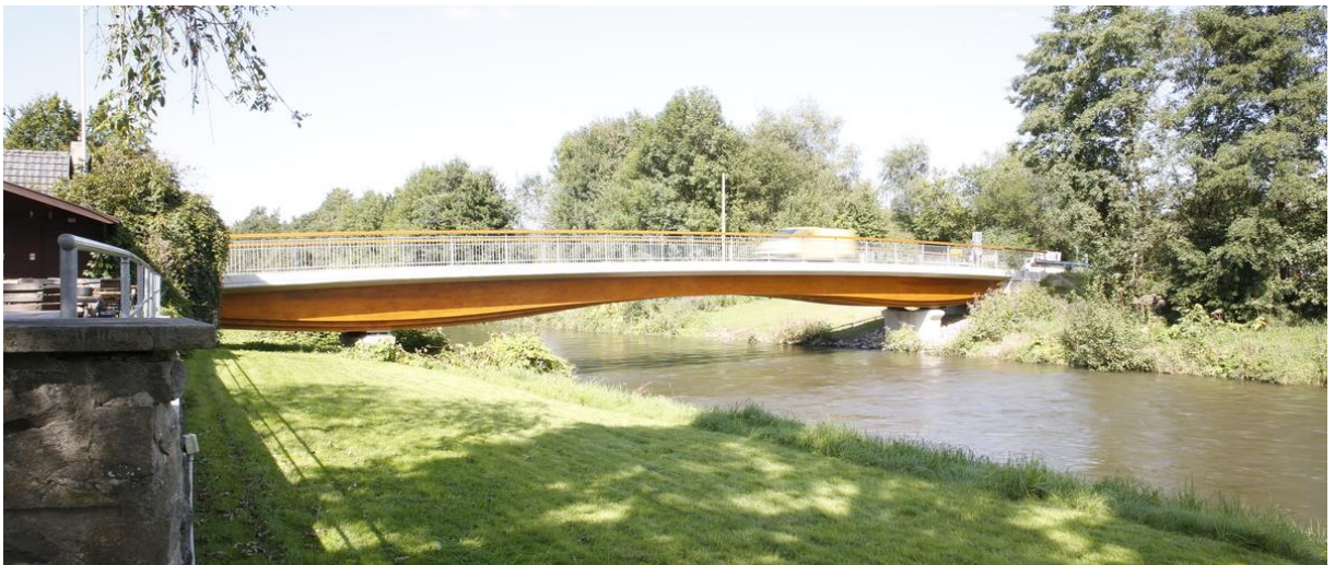
Obr. 24 - dřevo-betonový most v německém Lohmar Schiffarth tvoří dominantu krajiny. (zdroj: https://www.german-architects.com/en/ingenieurburo-miebach-lohmar/project/timber-concrete-composite-bridge-lohmar-de#image-2 )
