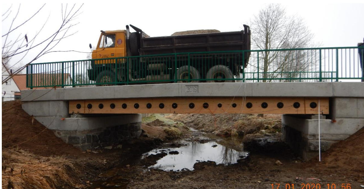
Obr. 48 - skutečné umístění zatěžovacího vozidla v zatěžovací situaci 1
