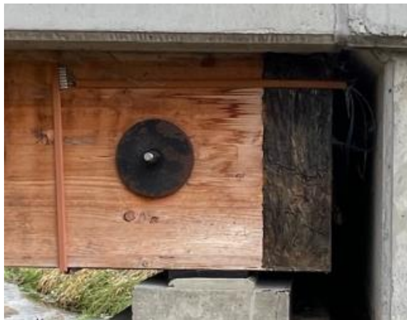
Obr. 32 - uložení LLD mostovky na elastomerové ložisko
