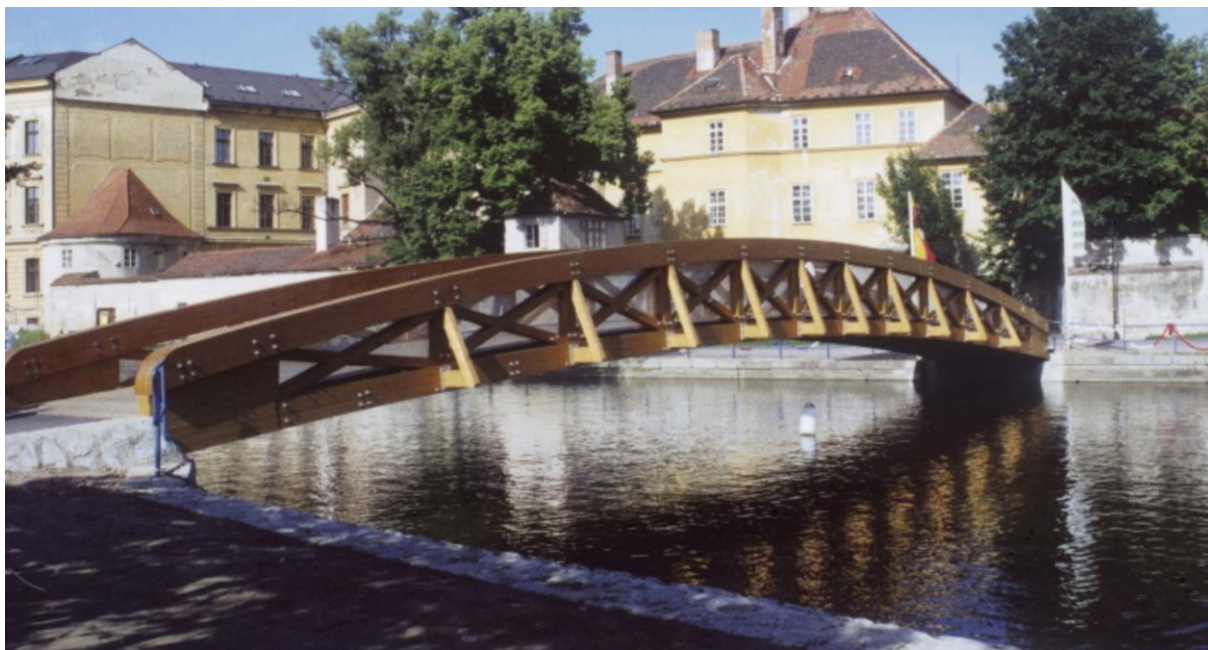
Obr. 9 - příhradová lávka v Českých Budějovicích (zdroj: TESKO s.r.o.)
