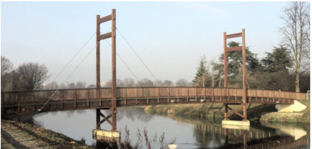
Obr. 11 - příklad zavěšeného dřevěného mostu
