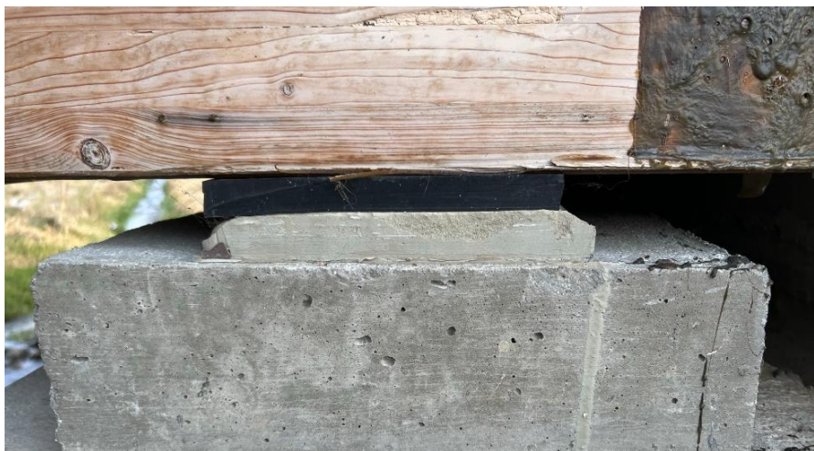
Obr. 39 - uložení LLD mostovky na elastomerové ložisko
