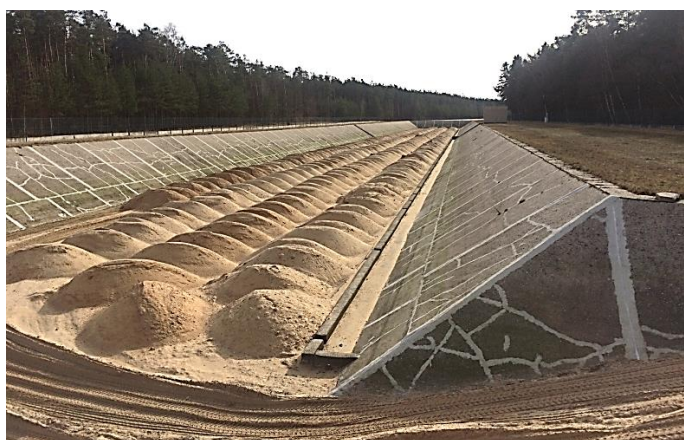
Příloha obr. 9 - Vsakovací nádrž při revitalizaci – doplnění nového křemičitého písku Zdroj: BRIXOVÁ; 2017 ( soukromý fotoarchiv )
