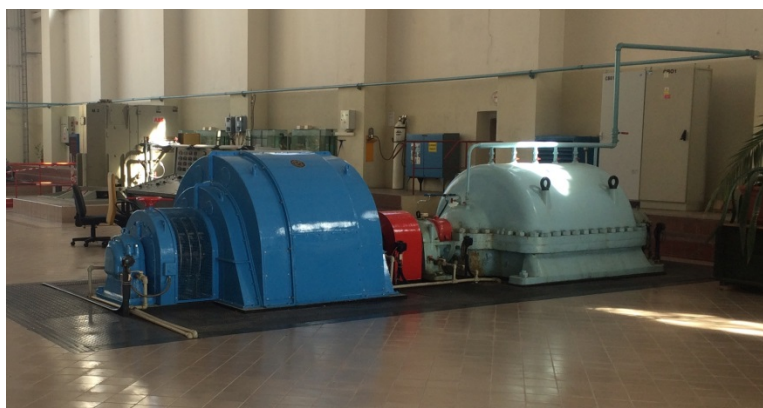
Příloha obr. 3 - Pohled na 1 ze 4 čerpadel v hlavní čerpací stanici Zdroj: BRIXOVÁ; 2017 ( soukromý fotoarchiv )
