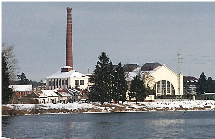
Příloha obr. 1 - Vodárna Káraný Zdroj: BRIXOVÁ; 2017 ( soukromý fotoarchiv )
