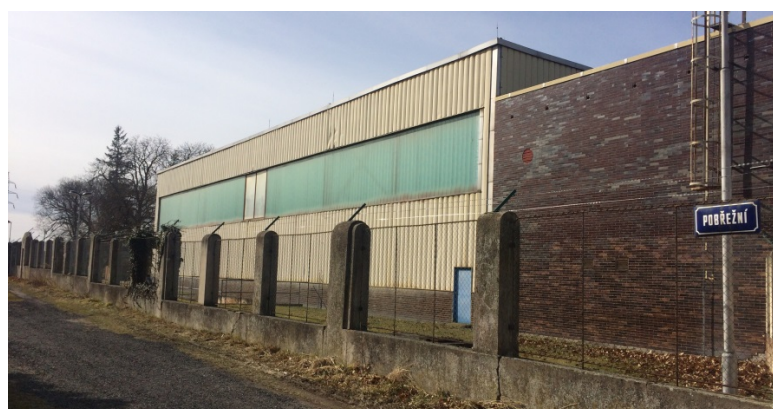
Příloha obr. 6 - Budova odželezovny pohled z Pobřežní ulice Zdroj: BRIXOVÁ; 2017 ( soukromý fotoarchiv )
