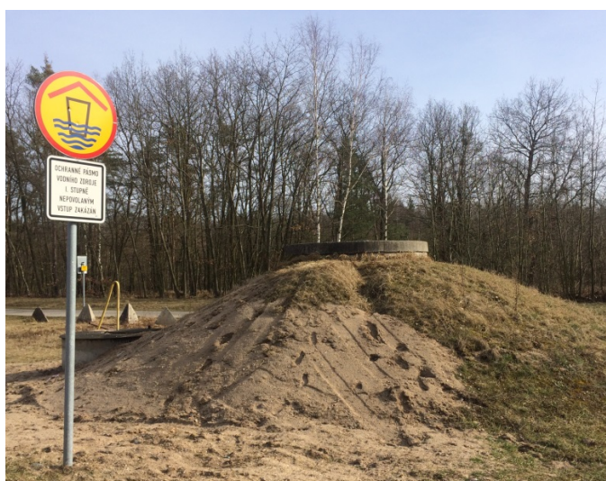
Příloha obr. 12 - Značka pásma ochrany vodního zdroje a studna typu Ranney Zdroj: BRIXOVÁ; 2017 ( soukromý fotoarchiv )
