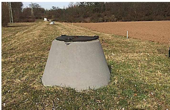
Příloha obr. 11 - Jímací studna Zdroj: BRIXOVÁ; 2017 ( soukromý fotoarchiv )
