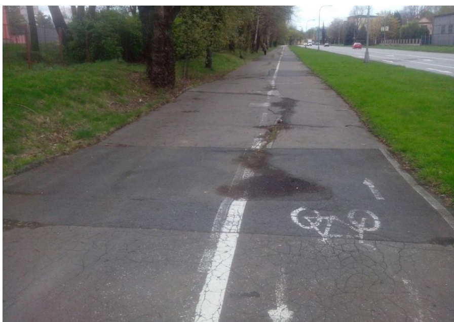
Obr. 36: Nerovnosti a výmolů Zdroj: autor, 2017
