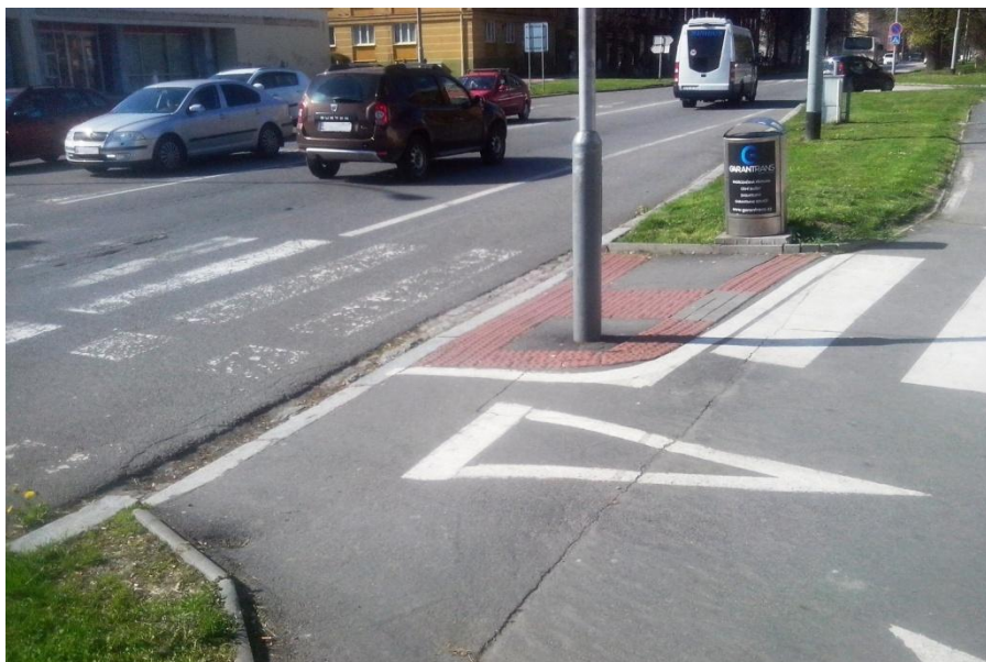
Obr. 22: Nerovnosti na přejezdu
