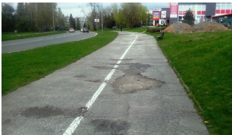
Obr. 38: Rozsáhlé výmoly
