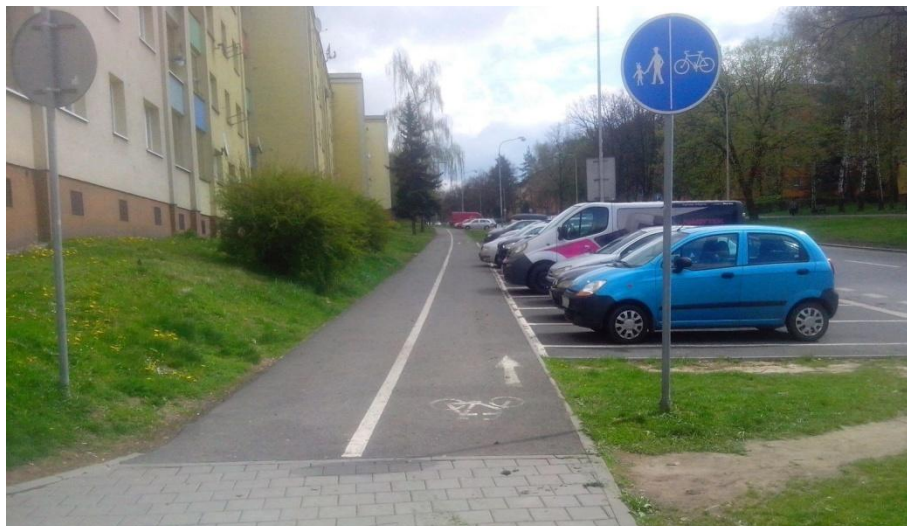
Obr. 34: Stezka narušena automobily ze šikmého parkování
