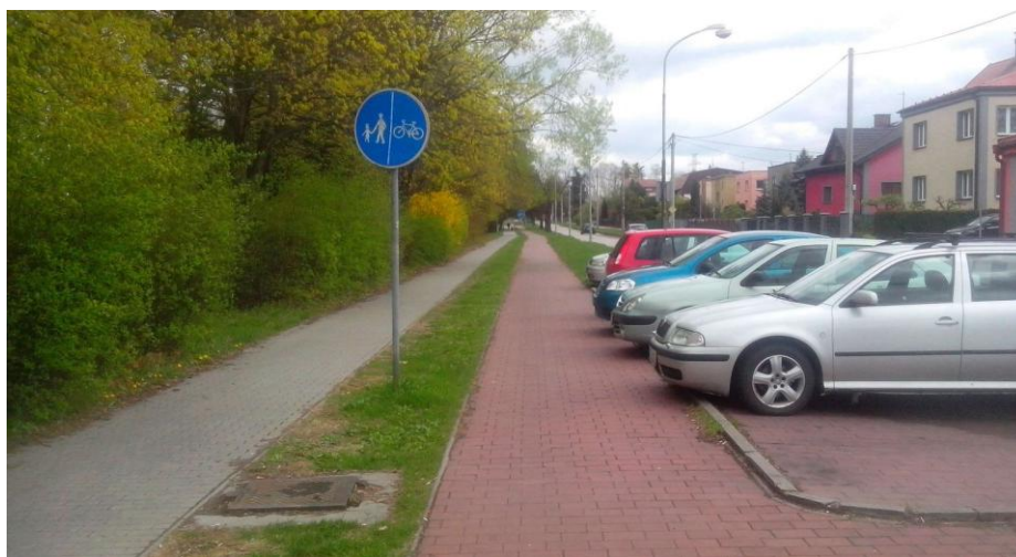
Obr. 35: Stezka narušena automobily ze šikmého parkování Zdroj: autor, 2017
