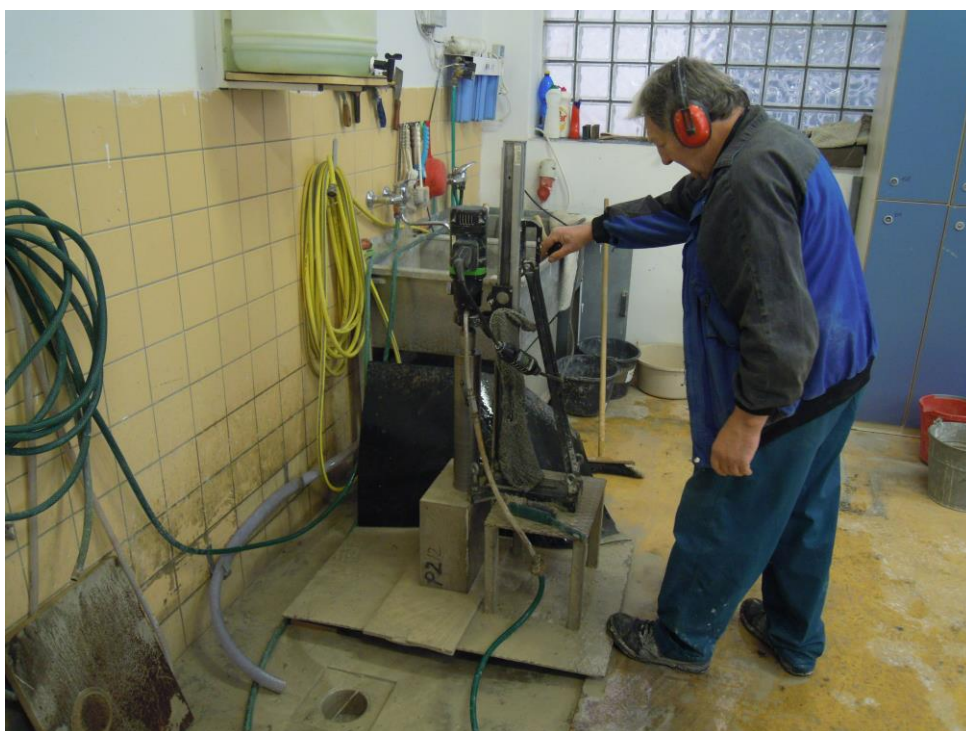
Obr. 13 Průběh jádrového vrtání
