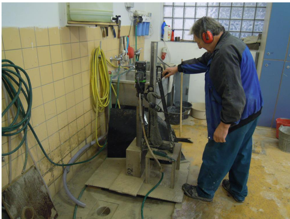
Obr. 13 Průběh jádrového vrtání
